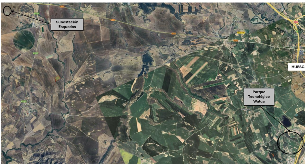
Figura 2. Ubicación de la subestación de Esquedas y del Parque Tecnológico de Walqa, Huesca
