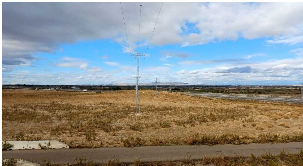
Figura. 2. Vista general de la actual línea de media tensión de 15 KV cruzando los términos municipales de Pedrola y Luceni. Algunos vanos disponen de balizas salvapájaros.
