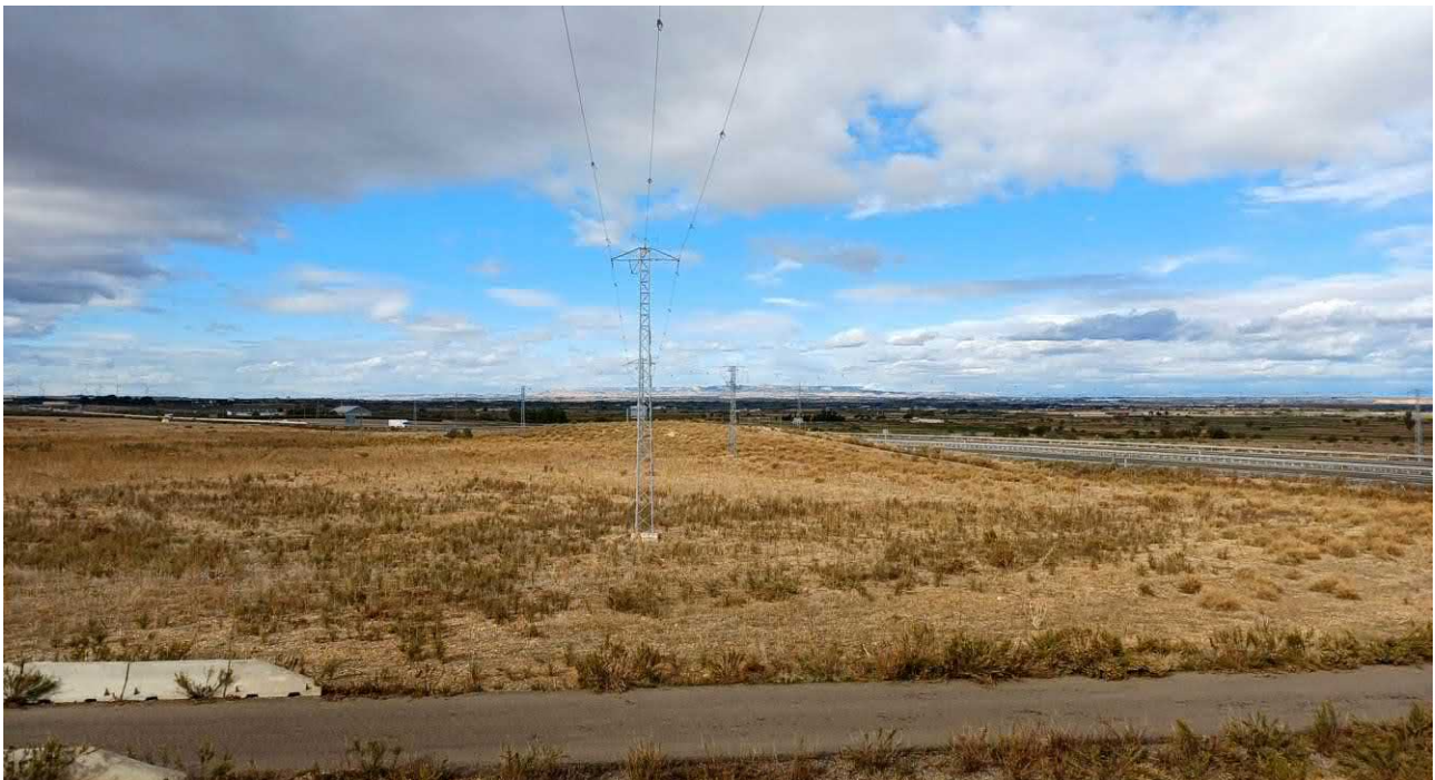
Figura. 2. Vista general de la actual línea de media tensión de 15 KV cruzando los términos municipales de Pedrola y Luceni. En algunos vanos dispone de balizas salvapájaros.
