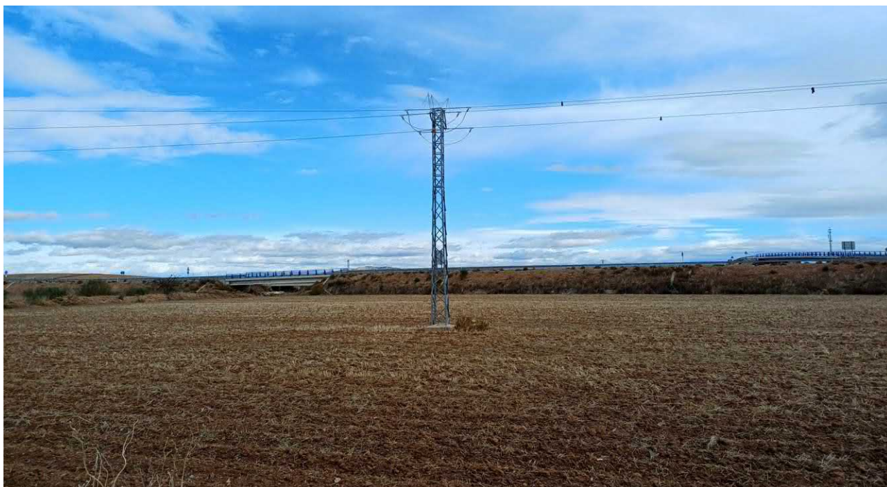
Figura. 4. Detalle del apoyo de la actual línea de media tensión sobre un campo de cultivo en el que se instalarán los apoyos D1, D2 y D3 del nuevo tramo de línea que cruzará la autovía A68.
