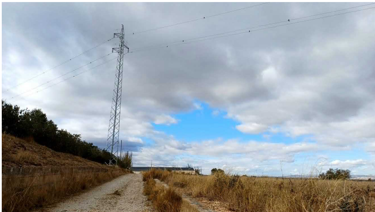
Figura. 3. Detalle de uno de los apoyos de la línea aérea actual situado en una finca privada. En algunos vanos dispone de balizas salvapájaros.
