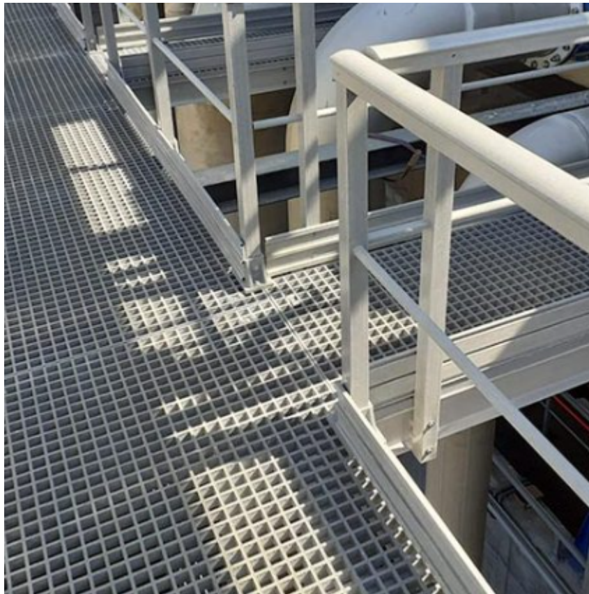
Imagen de ejemplo bancada de instalaciones proyectada.
