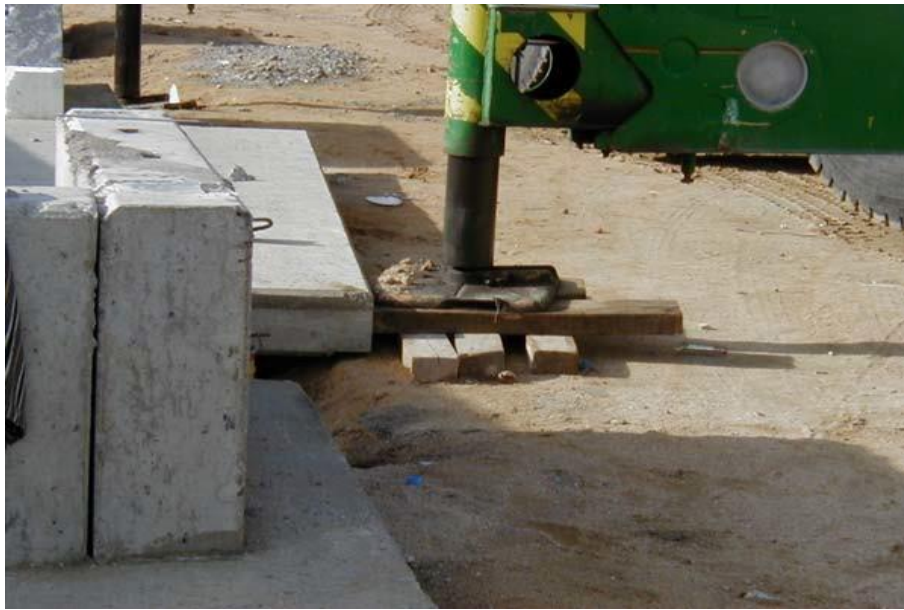
Buen apoyo de la grúa en el suelo. Uso de tablones de madera
