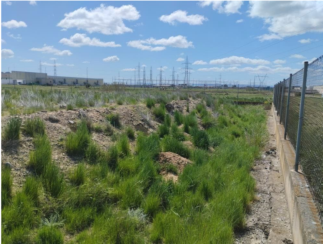
Figura 3.3.- Rellenos de tierras en parcela situada a la altura del p.k. 0+460
