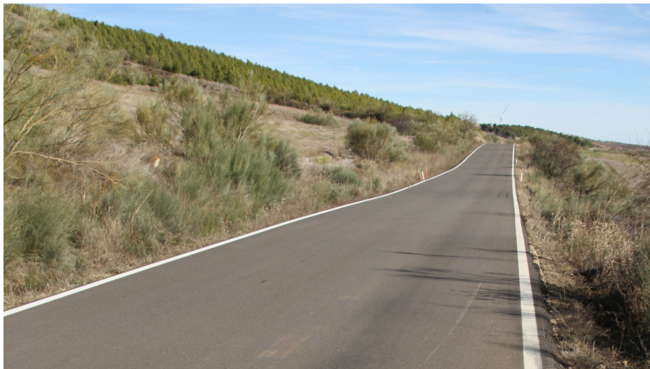
Figura 7.2: Carretera aragonesa que incumple normativa básica (fotografía propiedad de los autores). Ante un accidente laboral de tráfico ocurrido en esa carretera, la DGA defendió en sede judicial que su estado era correcto.
