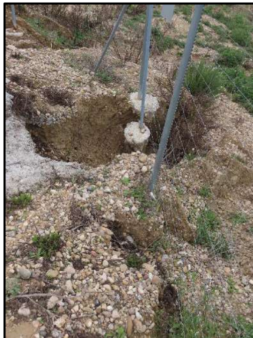
Fotografía 11. Poste del vallado afectado por la erosión por escorrentía (sector Norte)
