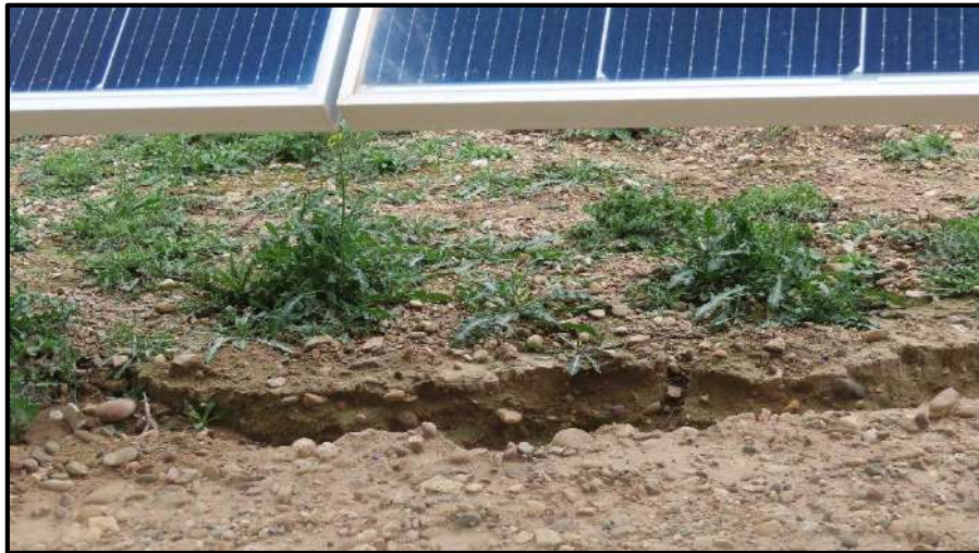
Fotografía 10. Regueros ocasionados por escorrentía bajo de las placas
