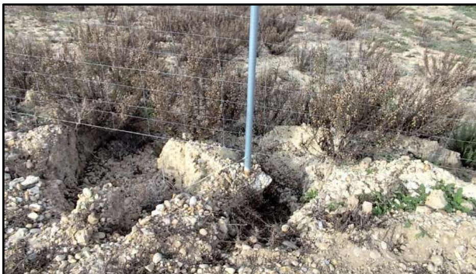
Fotografía 10. Poste del vallado afectado por la erosión por escorrentía (secto Norte)
