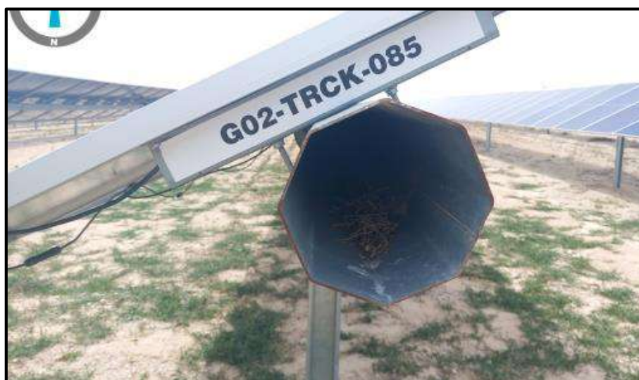
Fotografía 6. Ejemplo de intento de nidificación dentro de los tubos que soportan las placas
