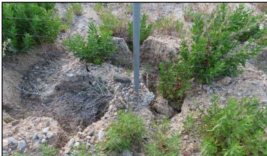
Fotografía 8. Poste del vallado afectado por la erosión por escorrentía
