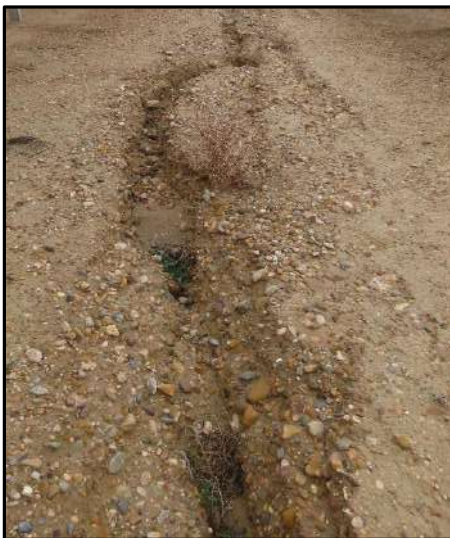
Fotografía 7. Dos puntos con mayor erosión originada por la circulación del agua.
