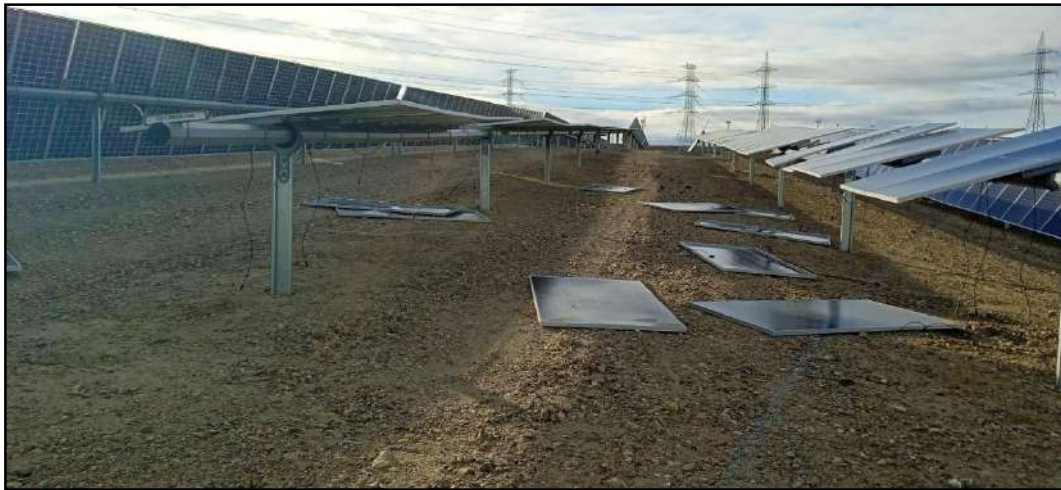
Fotografía 11. Diversas placas solares en el suelo tras temporal de viento (23/11/2023)
