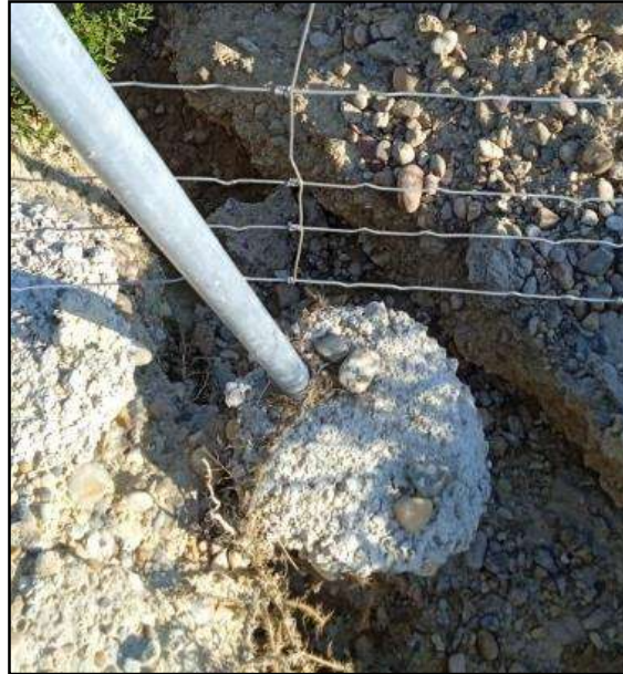
Fotografía 9. Cimentación desenterrada. Se aprecia una separación entre la base del vallado y el sustrato.
