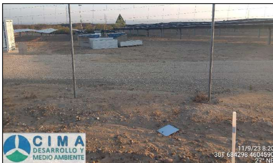
Fotografía 12. Placa anticolidión desprendida por el viento (11/09/2023)”
