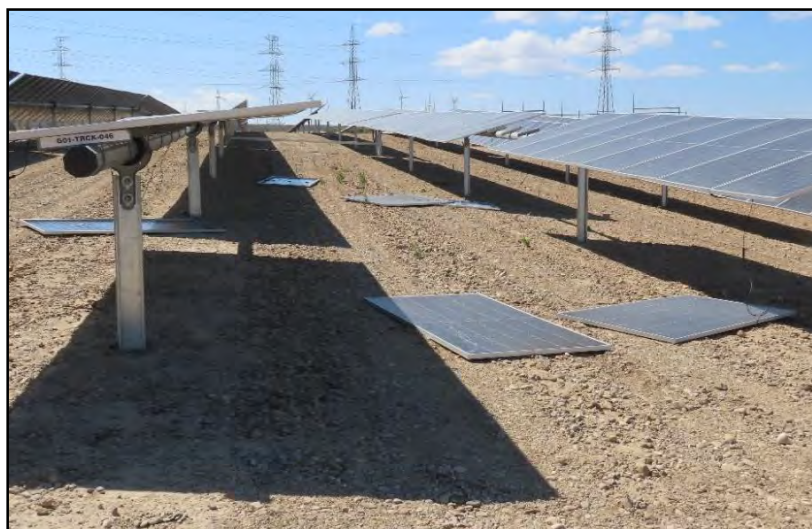
Fotografía 9. Diversas placas solares en el suelo tras temporal de viento (agosto 2023)”
