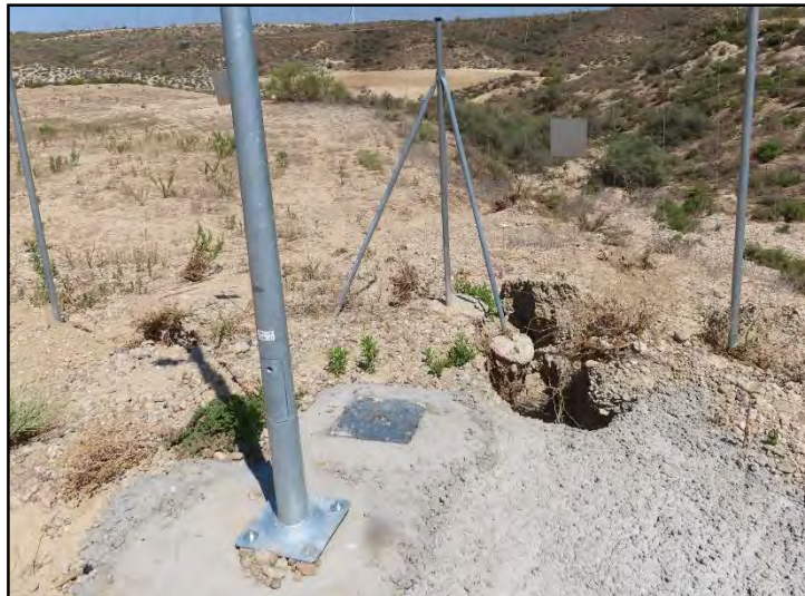
Fotografía 7. Cimentación desenterrada. Al fondo se aprecia una separación entre la base del vallado y el sustrato.
