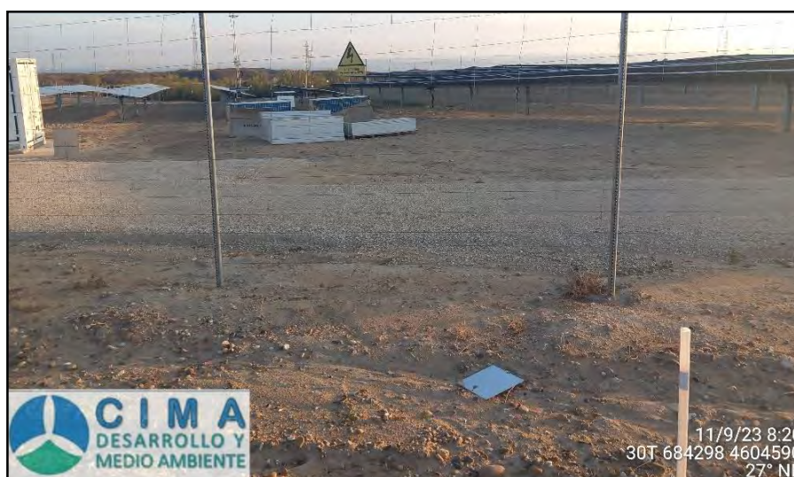
Fotografía 10. Placa anticollisión desprendida por el viento (11/09/2023)”
