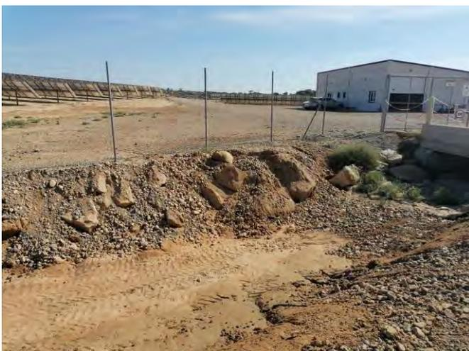
Fotografía 11.- Procesos erosivos. Reparación de cuneta junto a puente de acceso a la planta. Octubre de 2024.
