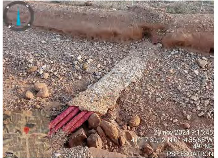
**Fotografía 14.-** Procesos erosivos asociados a escorrentía pluvial en el interior de la planta solar. Noviembre de 2024.
