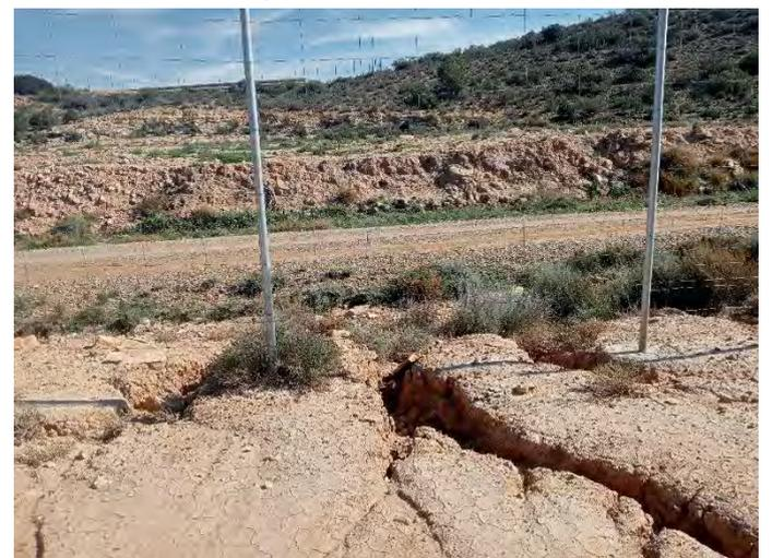
Fotografía 12.- Procesos erosivos. Pequeños surcos de escorrentía pluvial en el interior de la planta solar. Octubre de 2024.
