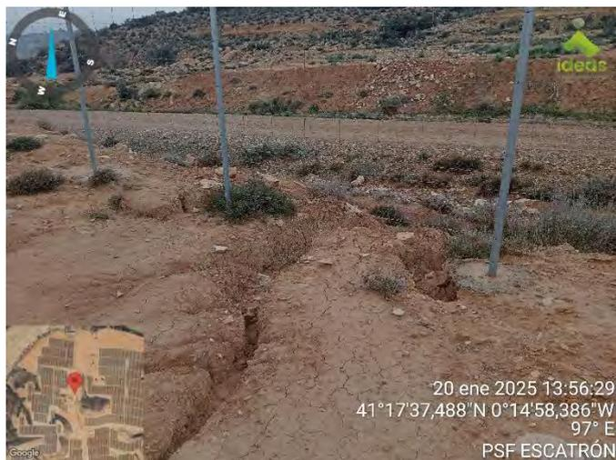
**Fotografía 17.-** Procesos erosivos. Cárcavas y arrastres junto al vallado perimetral debidas a lluvias torrenciales. Enero de 2025.
