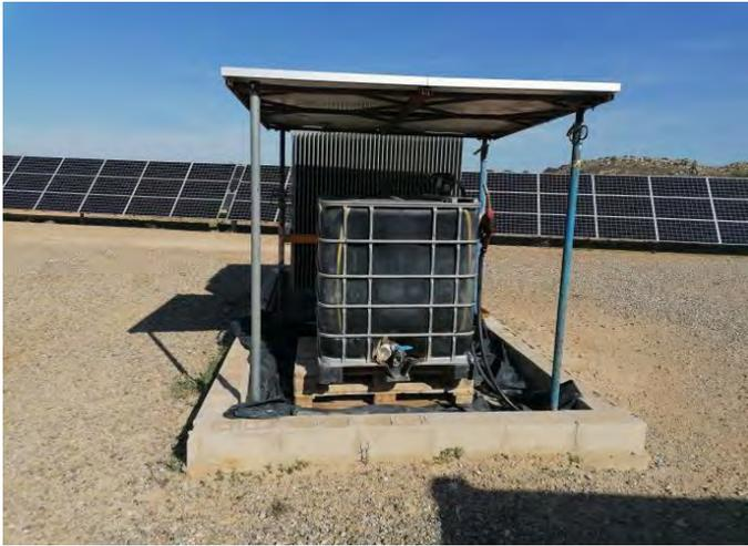
**Fotografía 49.** Gestión de residuos. Depósito de gasoil techado y con suelo impermeable, con bordes altos a modo de bandeja y aislado con plástico). Octubre de 2024.
