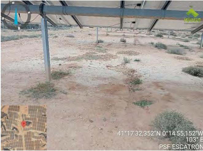
Fotografía 19.- Erosión. Procesos erosivos bajo seguidores. Enero de 2025.
