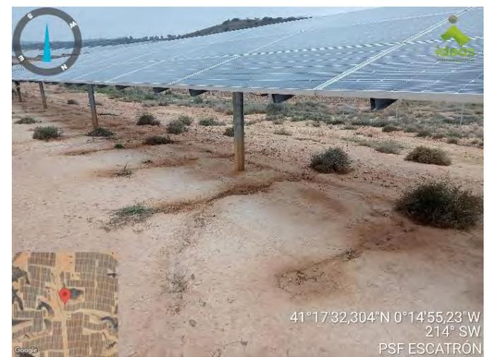
**Fotografía 18.-** Erosión. Inicio de cárcavas y arrastres bajoseguidores. Enero de 2025.
