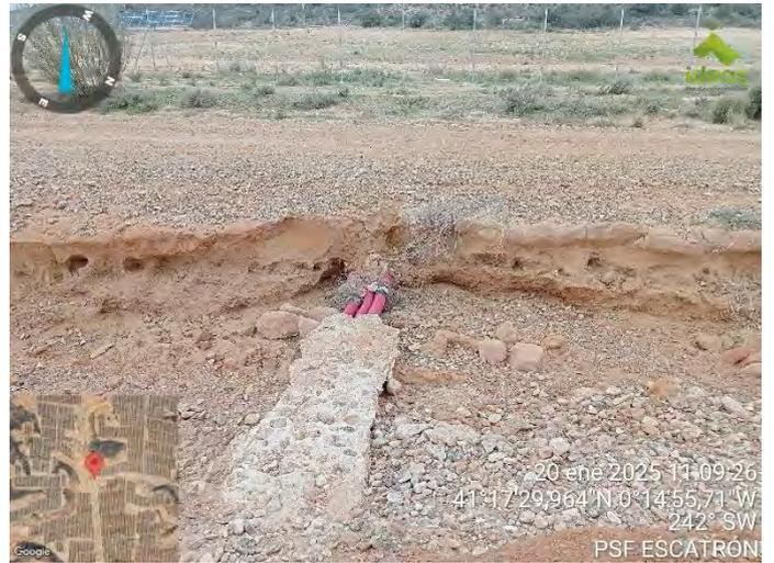
**Fotografía 16.-** Procesos erosivos asociados a escorrentía pluvial en el interior de la planta solar. Enero de 2025.
