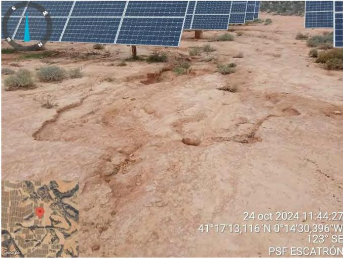
**Fotografía 13.-** Procesos erosivos asociados a escorrentía pluvial en el interior de la planta solar. Octubre de 2024.
