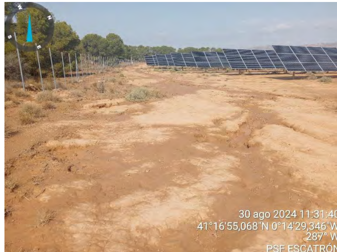
Fotografía 14.- Procesos erosivos asociados a escorrentía pluvial en el interior de la planta solar. Agosto de 2024.
