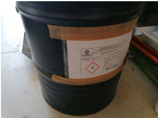
Fotografía 47.- Gestión de residuos: Residuos etiquetados y clasificados para su posterior retirada, con suelo impermeable y bandeja. Julio de 2024.
