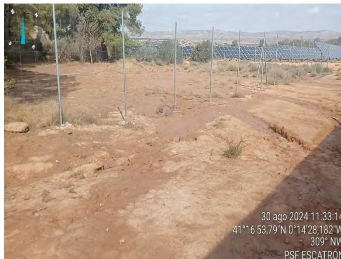
Fotografía 16.- Procesos erosivos asociados a escorrentía pluvial en el interior de la planta solar. Agosto de 2024.
