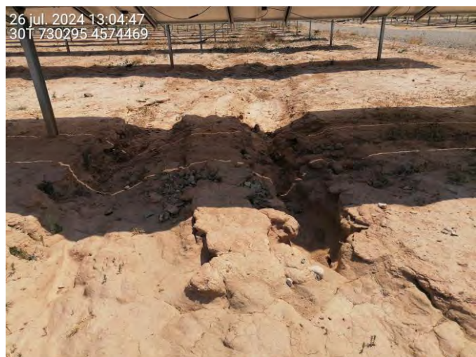
Fotografía 17.- Procesos erosivos. Cárcavas y arrastres bajo seguidores debidas a lluvias torrenciales. Julio de 2024.
