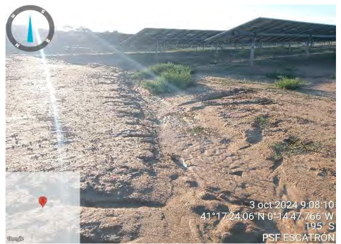
Fotografía 22.- Procesos erosivos. Cárcavas y arrastres bajo seguidores debidas a lluvias torrenciales. Octubre de 2024.
