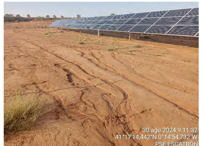
Fotografía 12.- Procesos erosivos. Pequeños surcos de escorrentía pluvial en el interior de la planta solar. Agosto de 2024.
