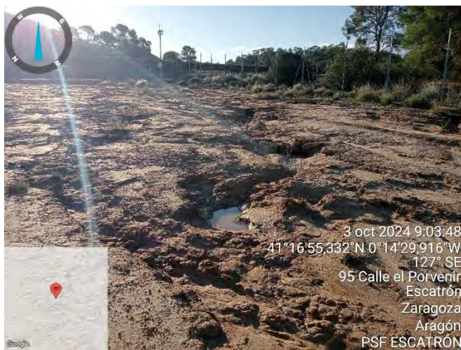
Fotografía 21.- Procesos erosivos. Cárcavas y arrastres bajo seguidores debidas a lluvias torrenciales. Octubre de 2024.
