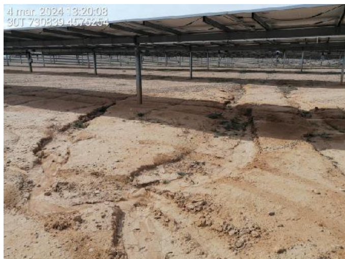
Fotografía 14.- Erosión. Inicio de hundimientos y grietas bajo seguidores. Marzo.
