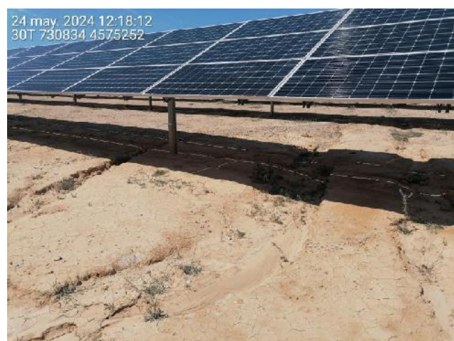
Fotografía 18.- Procesos erosivos. Cárcavas y arrastres bajo seguidores debidas a lluvias torrenciales. Mayo.
