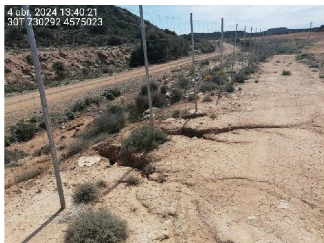
Fotografía 16.- Procesos erosivos. Cárcavas y arrastres bajo el vallado debidas a lluvias torrenciales. Abril.
