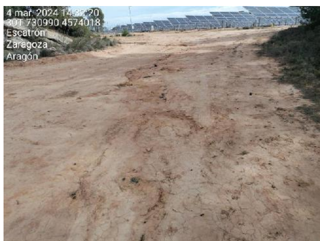
Fotografía 13.- Procesos erosivos. Cárcavas y arrastres bajo seguidores debidas a lluvias torrenciales. Febrero.
