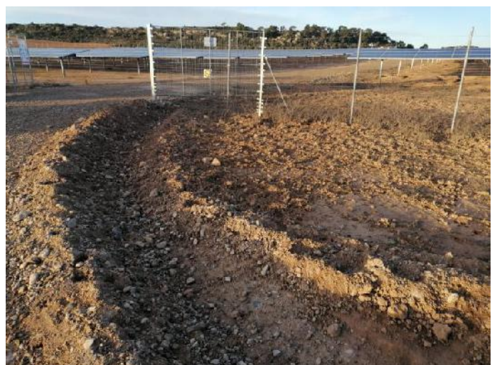
Fotografía 12.- Procesos erosivos. Reparación realizada en cuneta por operarios de la planta. Febrero.
