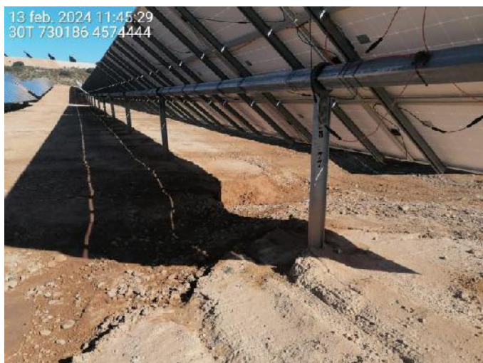
Fotografía 13.- Procesos erosivos. Cárcavas y arrastres bajo seguidores debidas a lluvias torrenciales. Febrero.
