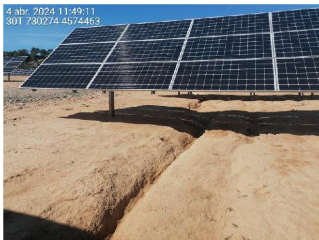
Fotografía 17.- Procesos erosivos. Cárcavas y arrastres bajo seguidores debidas a lluvias torrenciales. Abril.
