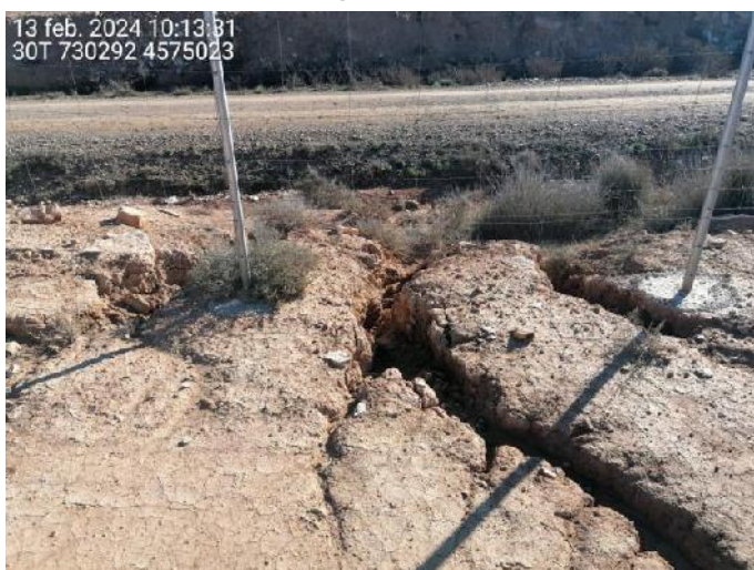
Fotografía 11.- Procesos erosivos. Cárcavas y arrastres bajo el vallado debidas a lluvias torrenciales. Febrero.
