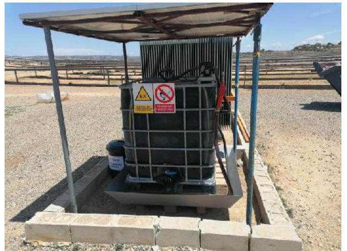
Fotografía 42.- Depósito de gasoil techado y con suelo impermeable. con bordes altos a modo de bandeja y aislado con plástico). Mayo.
