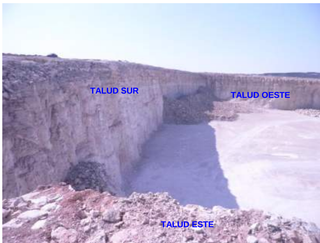
Ilustración 15. Taludes de la cantera Macondo.
