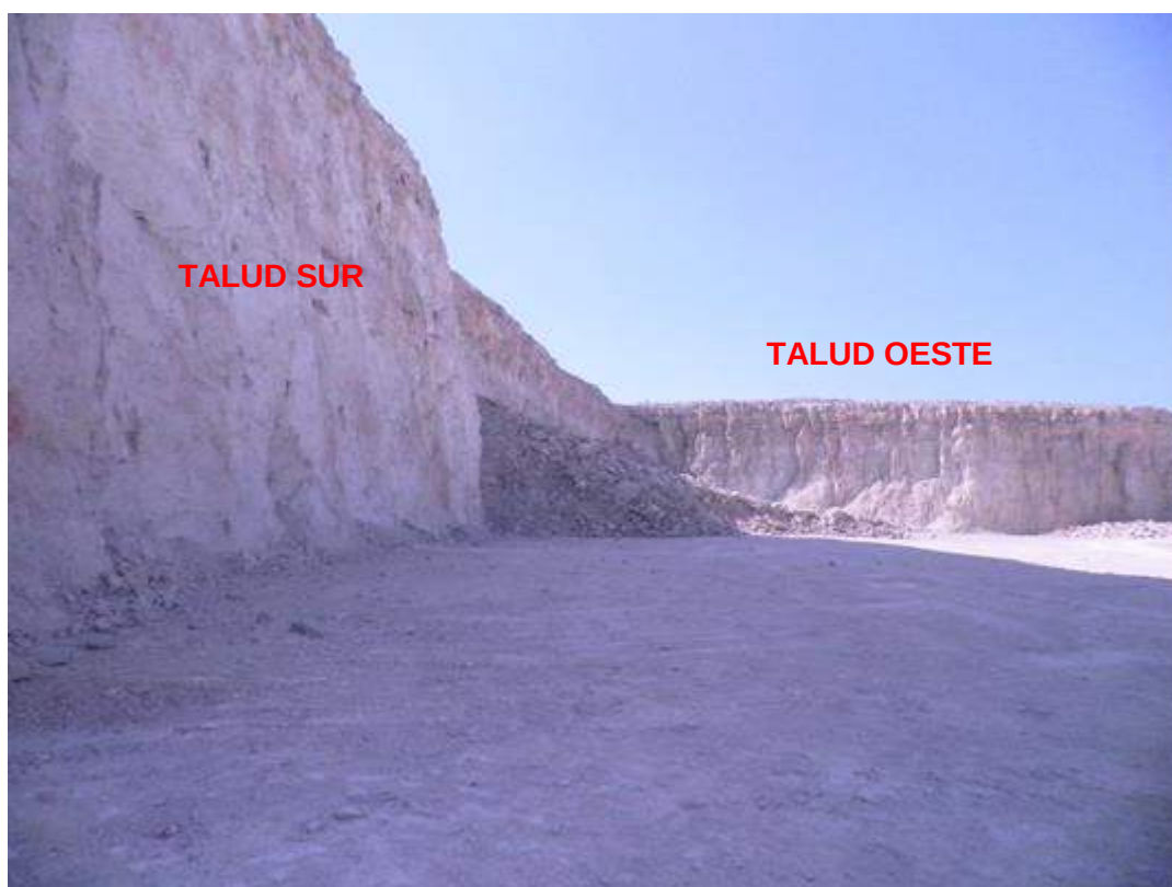
Ilustración 4. Banco en explotación (Fuente: LOM, 2017).
