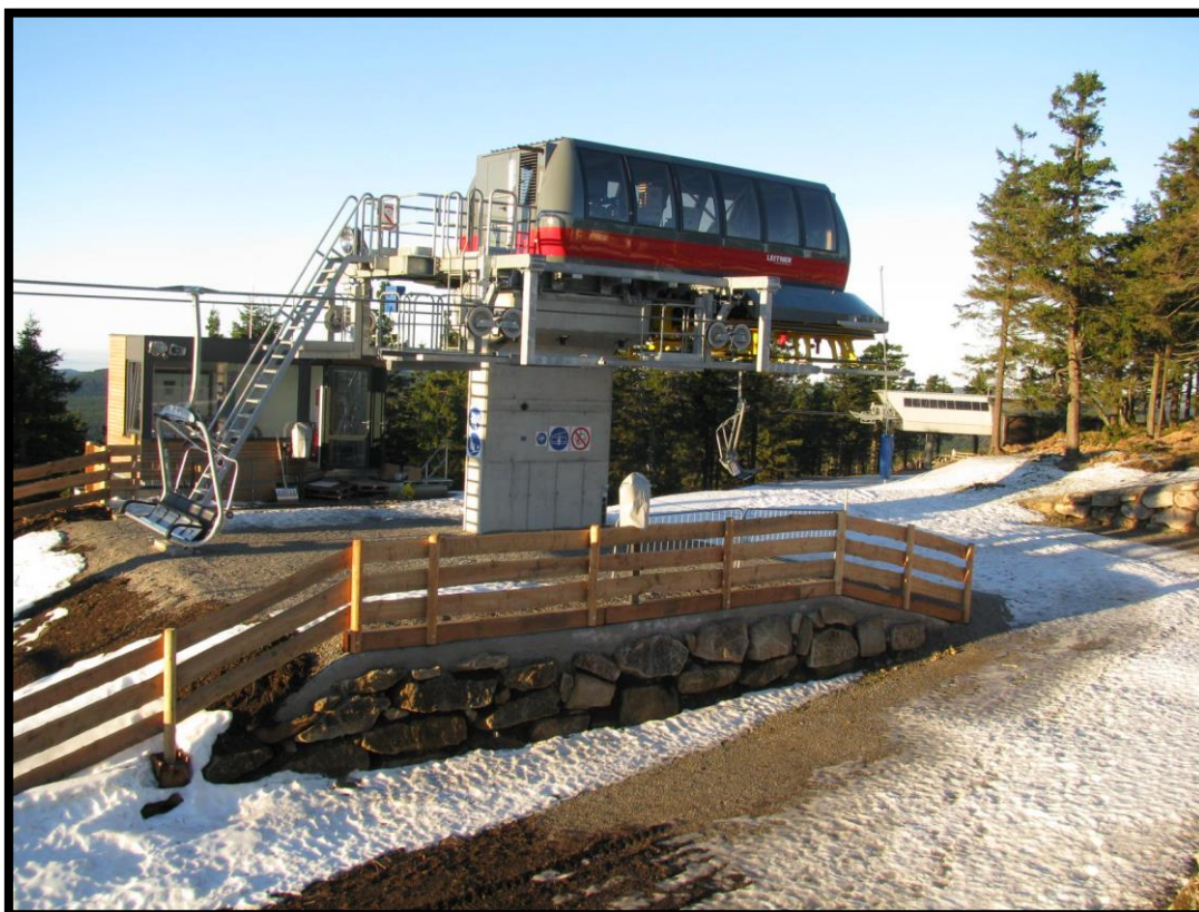
Estación motriz con cubierta alta
