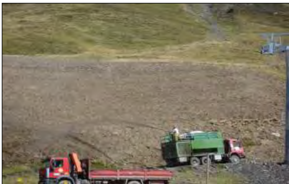
Imagen 10. Labores de hidrosiembra en taludes realizadas en la estación de Astún, en el año 2010. Foto cedida por la estación de esquí de Astún.
