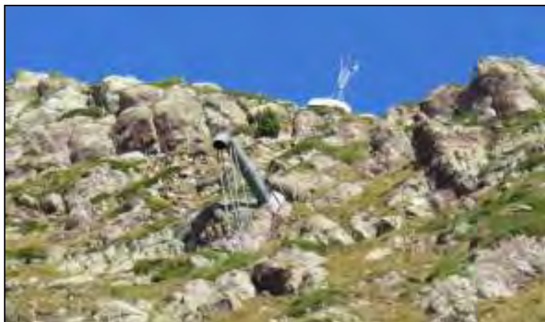
Gazex. Infraestructura para provocar aludes controlados.
