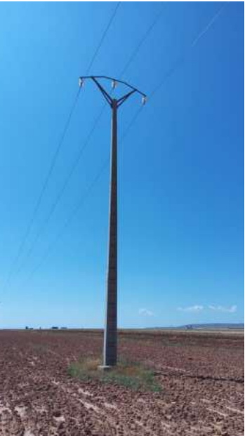
Apoyo 22 existente a sustituir
