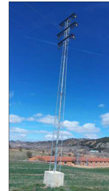
Apoyo 142/7 existente a sustituir
