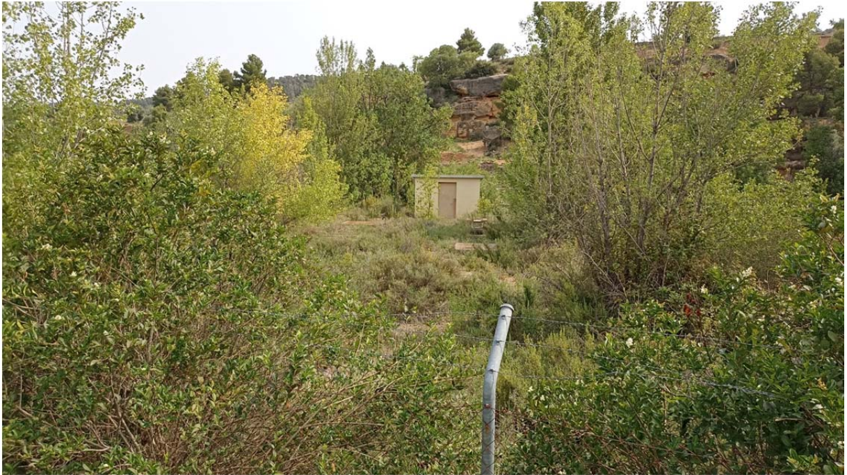
Fotografía 1: Antigua EDAR de Belmonte de San José.
