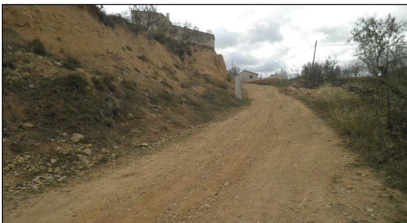
Estado del camino de acceso hasta la nueva E.D.A.R. desde el núcleo de Belmonte de San José.
