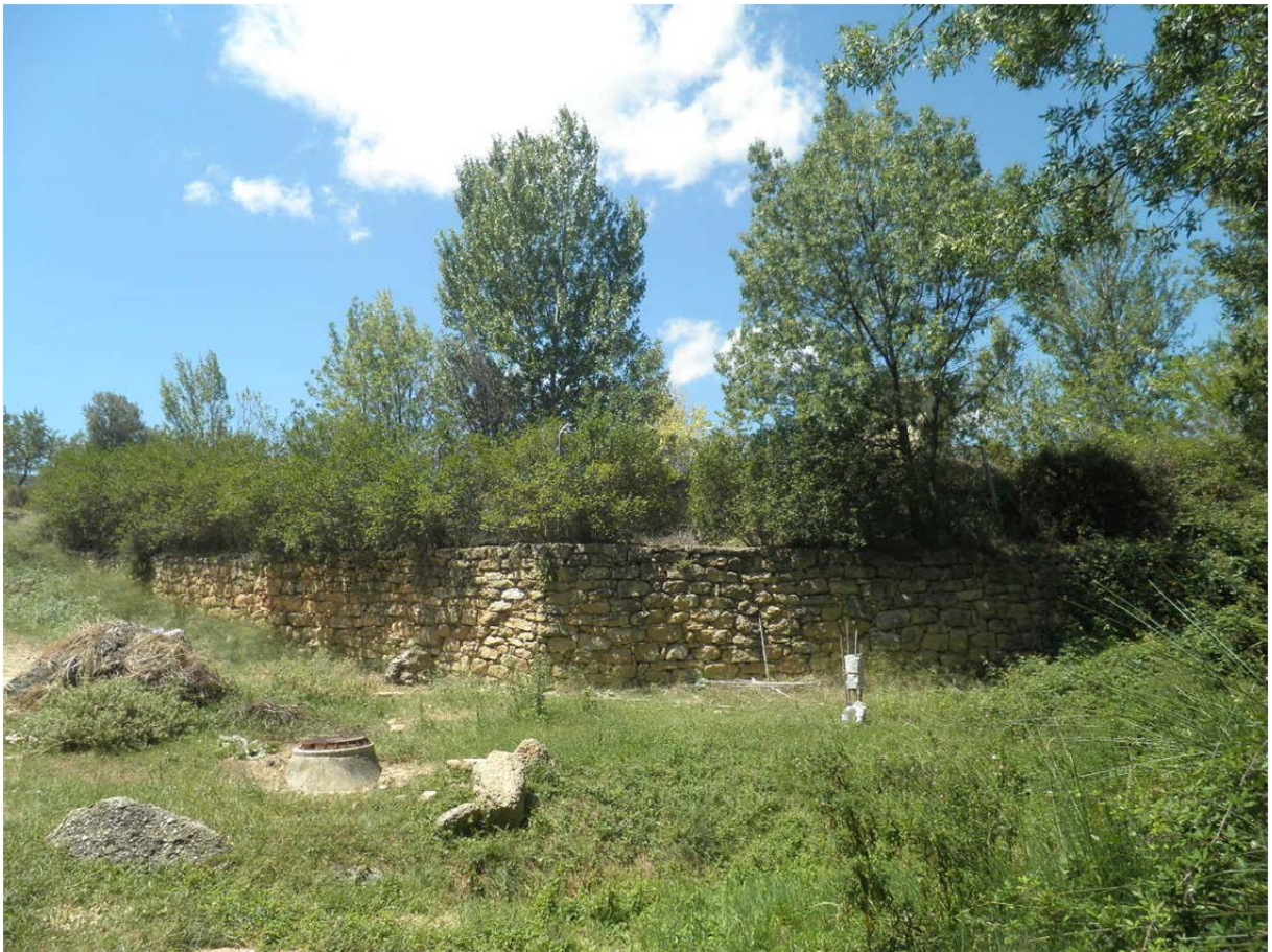
Fotografía 2: Antigua EDAR de Belmonte de San José.
