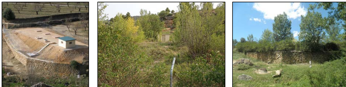
De izda a dcha, vista de la E.D.A.R. tras su construcción, su estado actual y el pozo de entrada.
