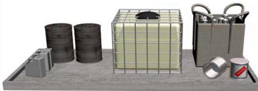
Cubeto impermeabilizados para almacenamiento de residuos peligrosos
