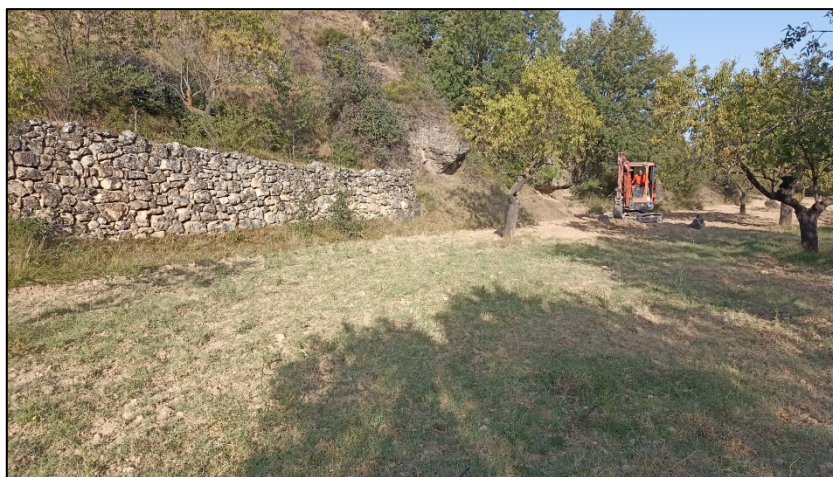
Parcela en la que se ubica la nueva E.D.A.R., en el momento de la realización de las catas.
