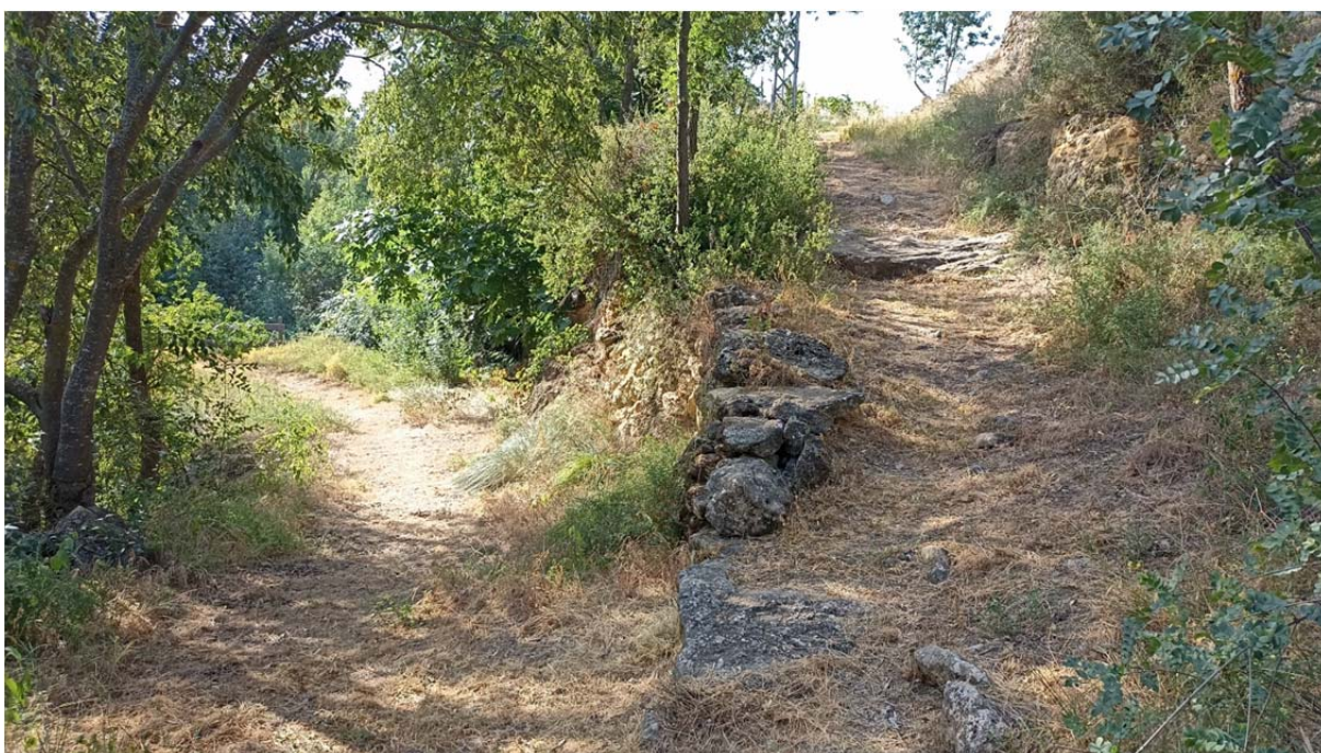
Fotografía 8: Acceso a la zona oeste de la parcela de implantación de la nueva EDAR por donde discurrirá en colector oeste (Camino a la derecha de la fotografía)
