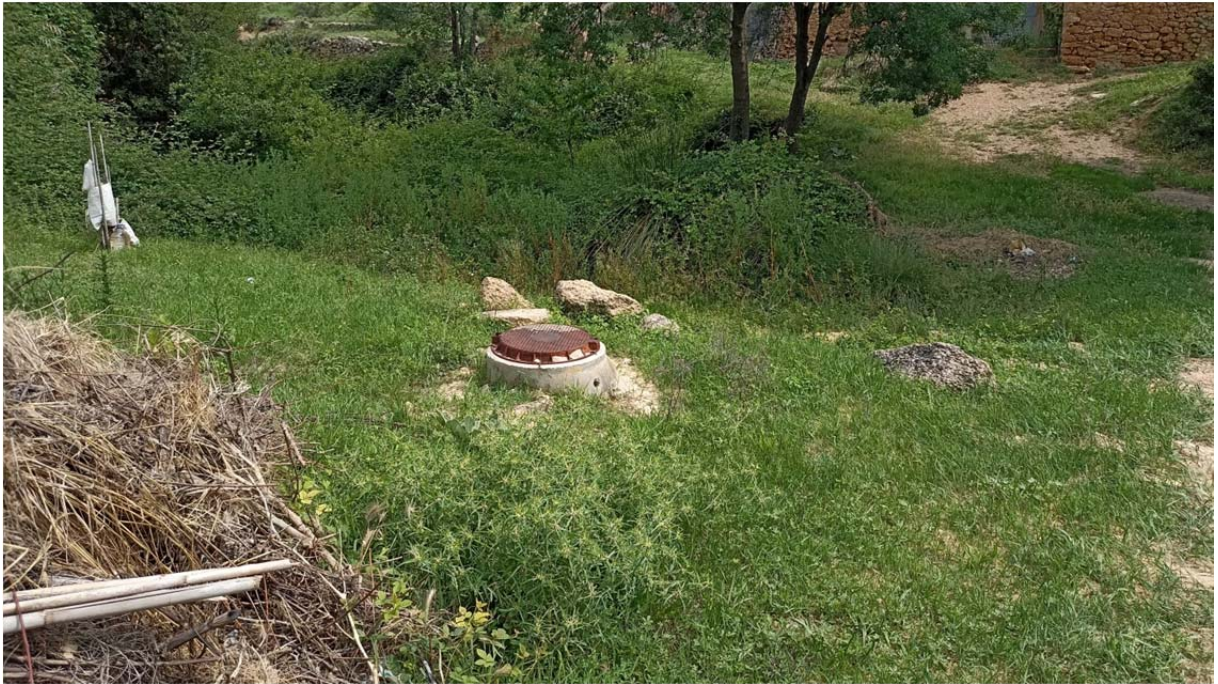
Fotografía 3: Punto de vertido actual sin depurar en barranco de la Luna o barranco de las Tozas en Belmonte de San José.
