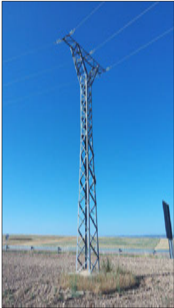
Apoyo 43 existente a sustituir
