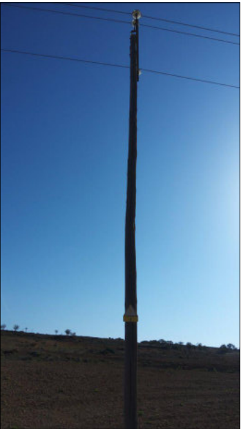
Apoyo 8 existente a sustituir
