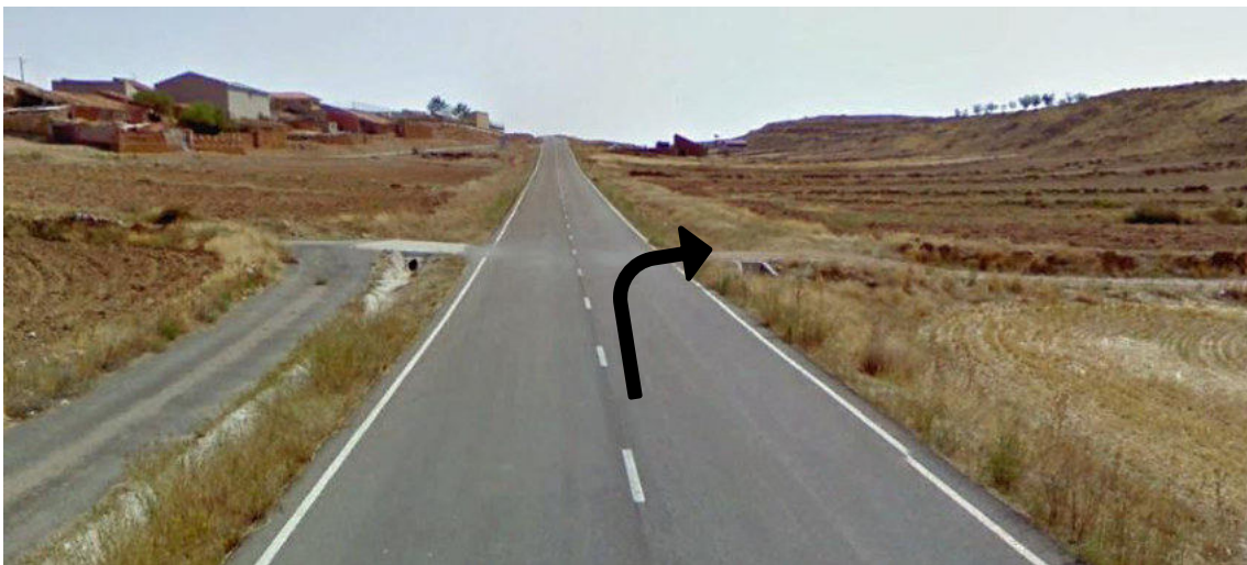
Ilustración 8: Camino de acceso del PFV.
