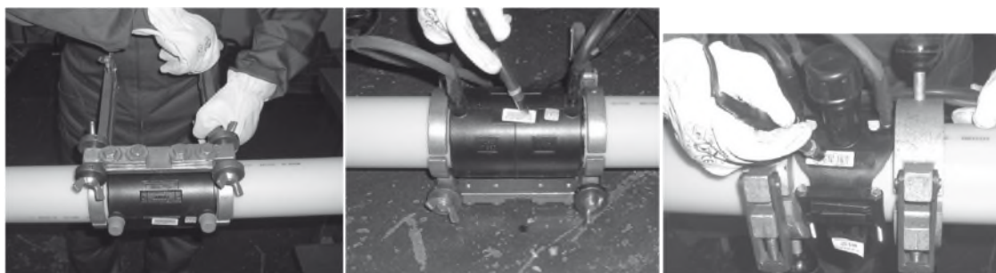
Soldadura por electrofusión. Tubería de igual diámetro y accesorios de derivación.
