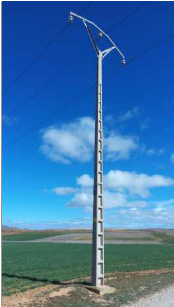
Apoyo 174 existente a sustituir
