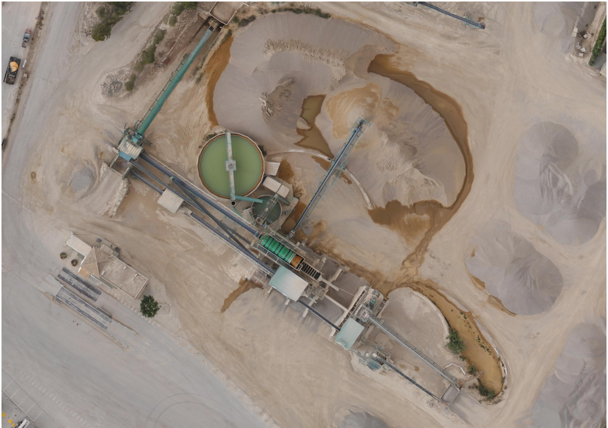
Figura 3.1 Vista aérea de la planta de tratamiento por vía húmeda
