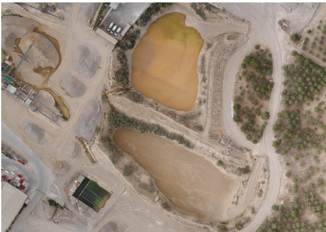
Figura 3.4 Vista aérea de las balsas
