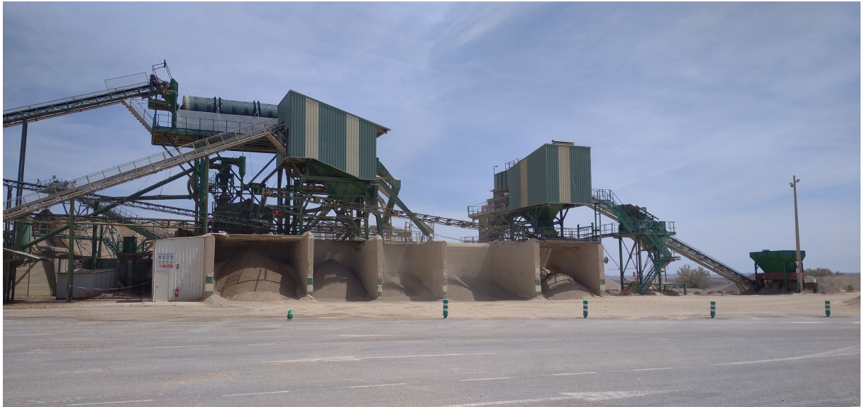
Figura 3.2 Vista de la línea de lavado, criba y silos y línea de molienda (molino terciario)
