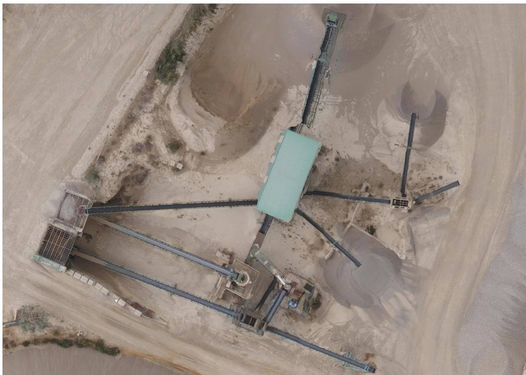
Figura 3.3 Vista aérea de la planta de tratamiento por vía seca
