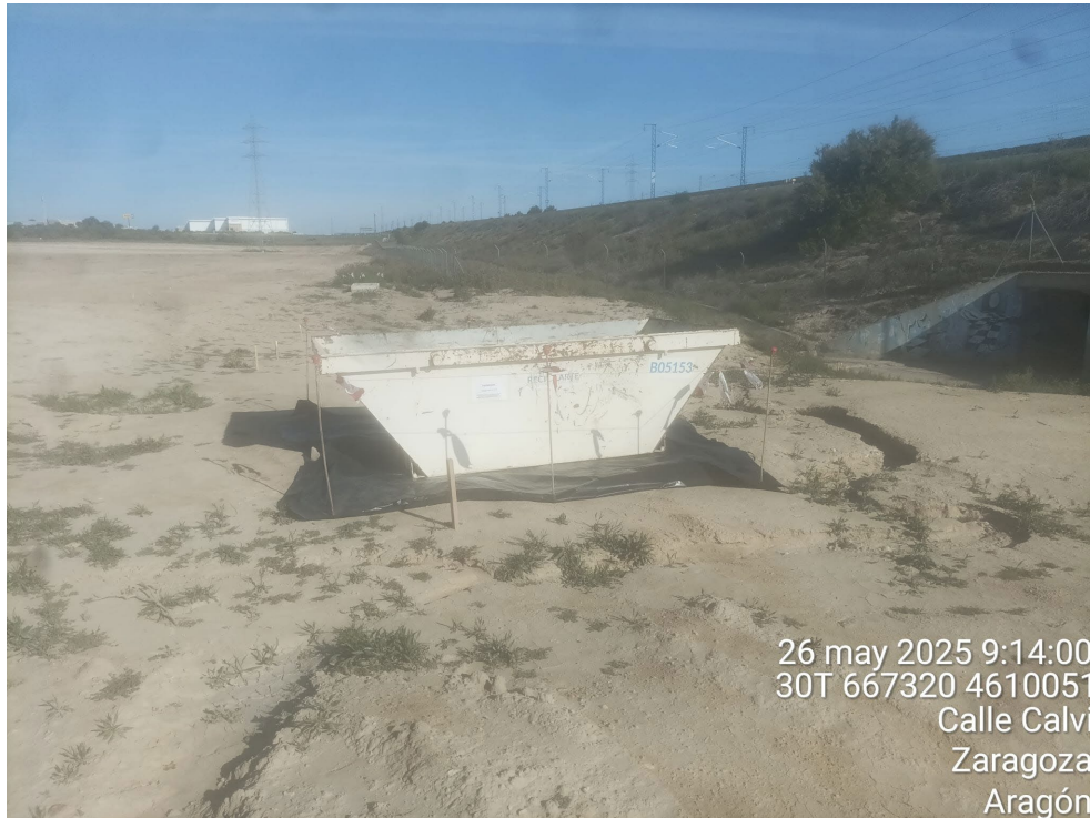
Ilustración 1. Contenedor de residuos del lavado de hormigón del vallado
