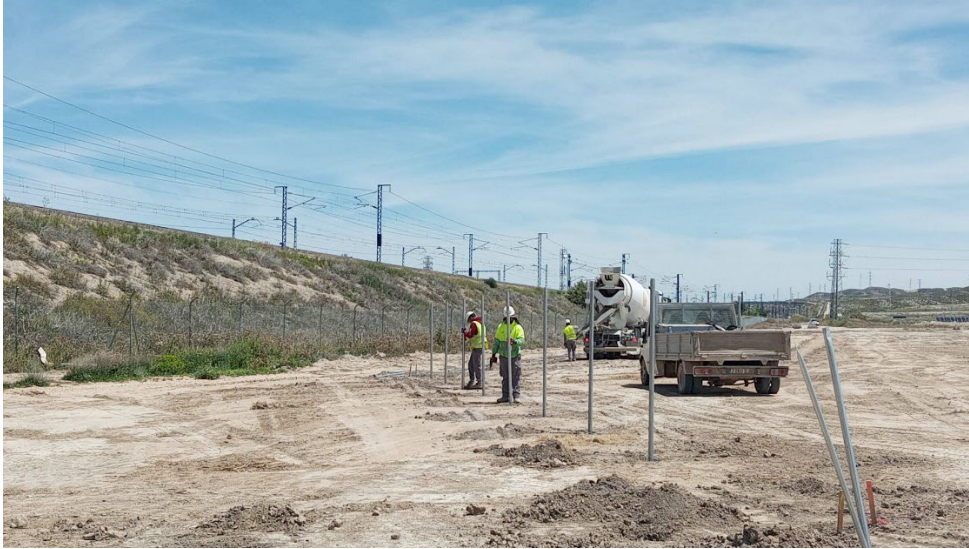
Ilustración 2. Instalación postes de cimentación del vallado
