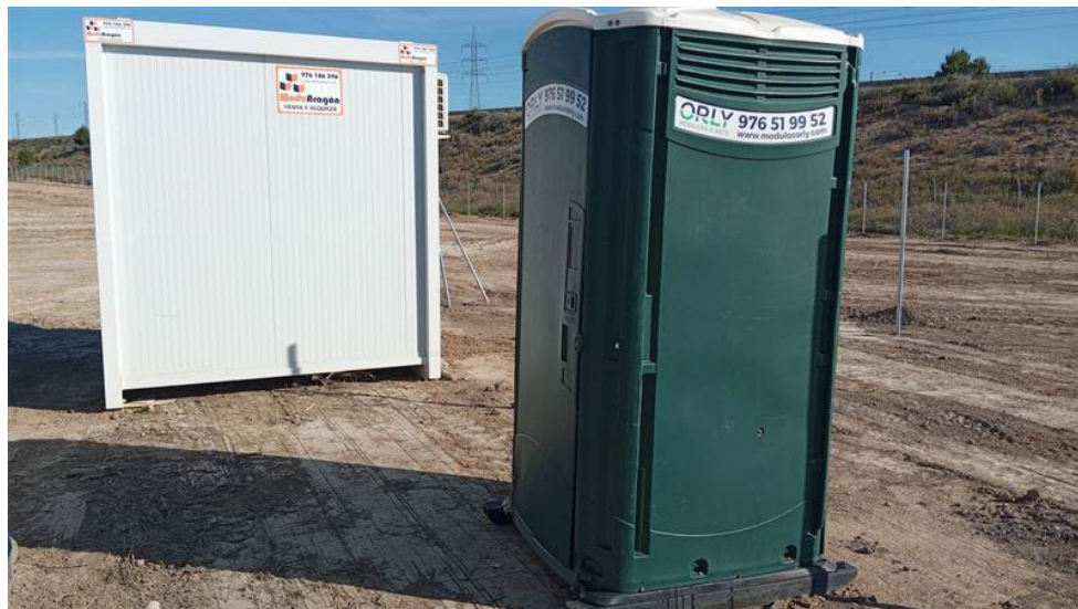
Ilustración 2. Instalación baño químico en campa
