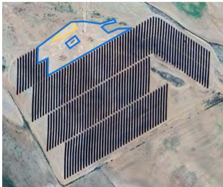
Imagen 8. Zona libre de módulos a extender tierra vegetal y descompactar CT_06.
