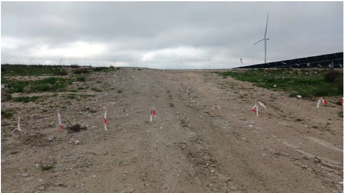
Imagen 20. Afección 9 presencia de zanja.
