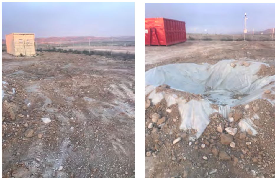
Foto 32: retirada de balsa y construcción de nueva.
