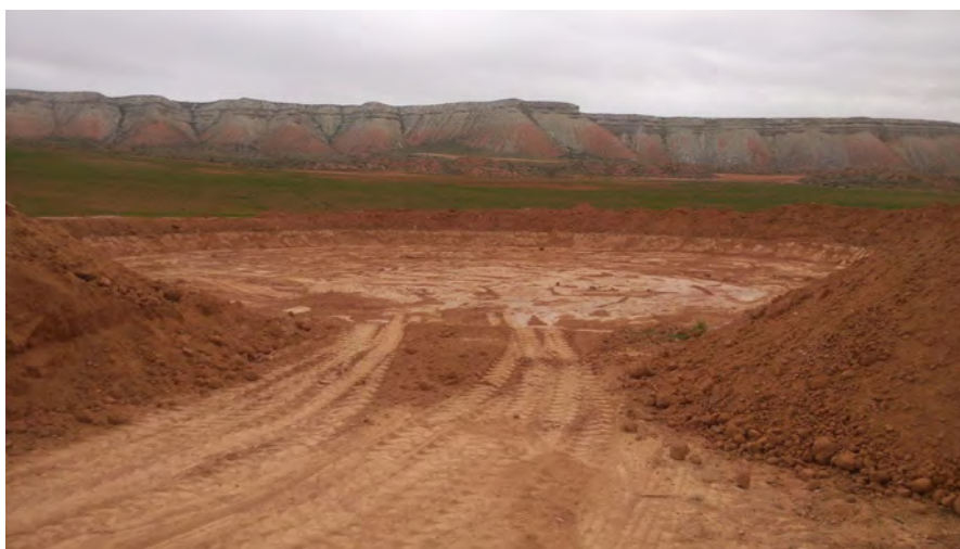
Foto 33: Ejecución de balsa bebedero.
