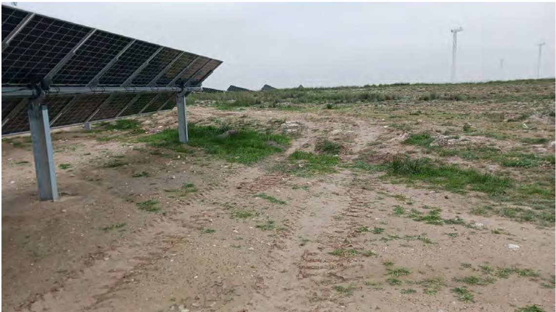
Imagen 16. Afección 6, rodad indebida y presencia de zanja.
