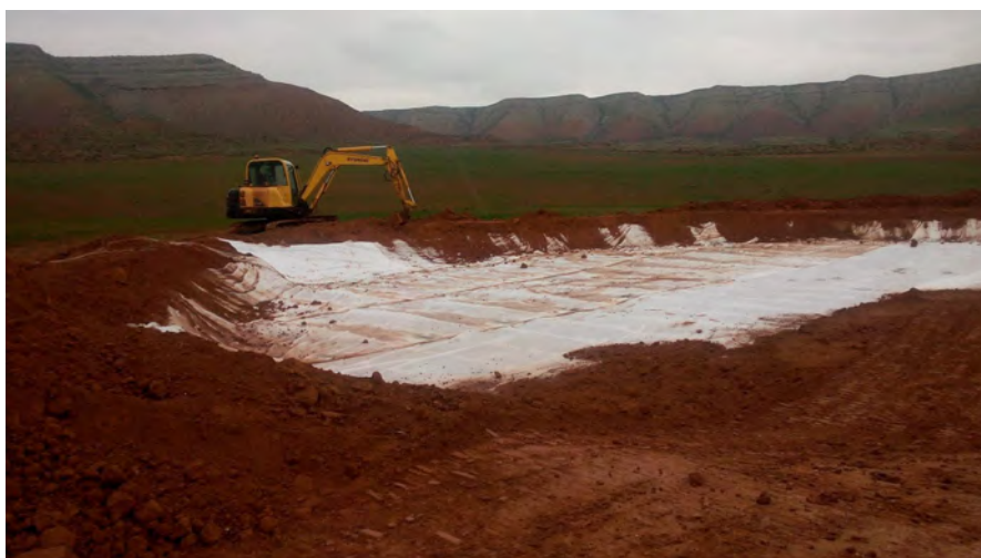
Foto 33: Ejecución de balsa bebedero.
