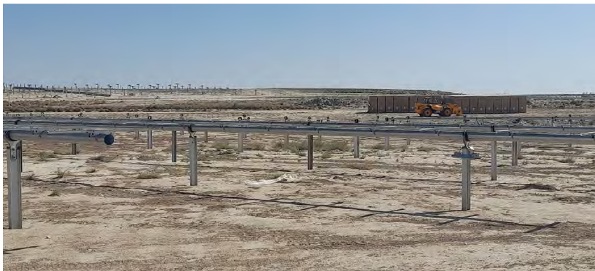
Foto 14: Instalación de trackers:
