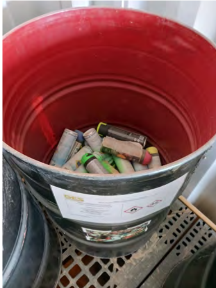
Foto 5 y 6: segregación y etiquetado de residuos peligrosos.
