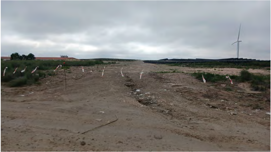
Imagen 19. Afección 8 presencia de zanja.
