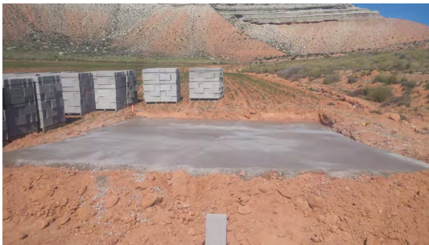
Foto 35: ejecución de losa para edificación del primillar.
