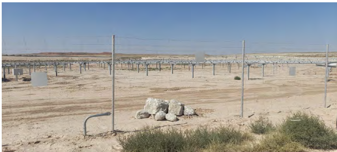
Foto 13: Instalación de majanos de reptiles y pasos de fauna.
