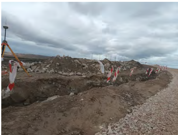
Foto 3 y 4: apertura de zanja e instalación del vallado.
