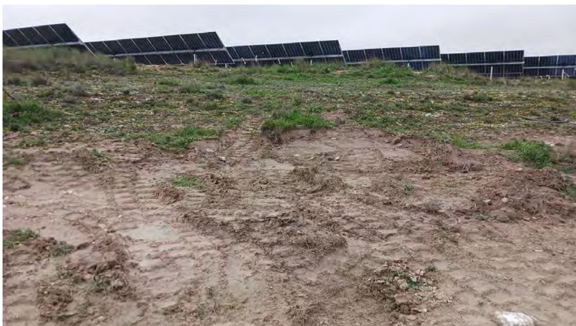
Imagen 12. Afección 2, acopio indebido.
