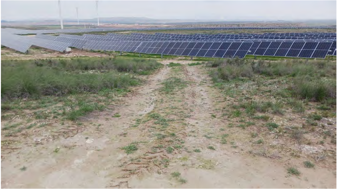
Imagen 13. Afección 3, rodada indebido.
