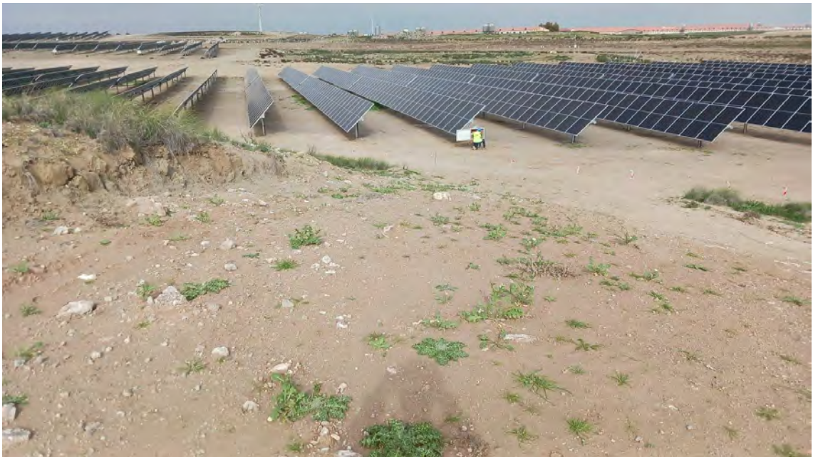
Imagen 22. Afección 11 presencia de zanja.
