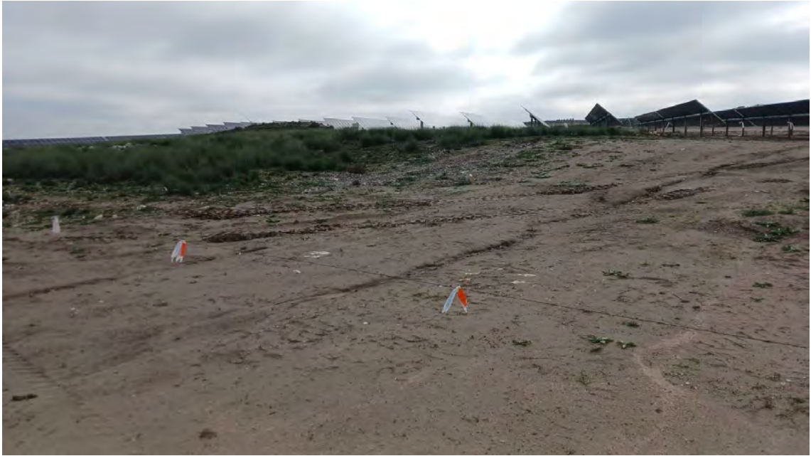
Imagen 19. Afección 10 presencia de zanja.
