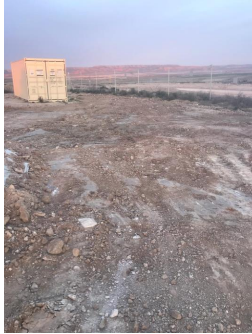
Foto 2: retirada de residuos de hormigón
