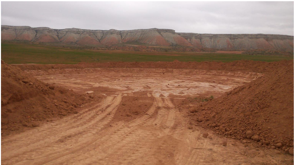
Foto 3: Ejecución de balsa bebedero.
