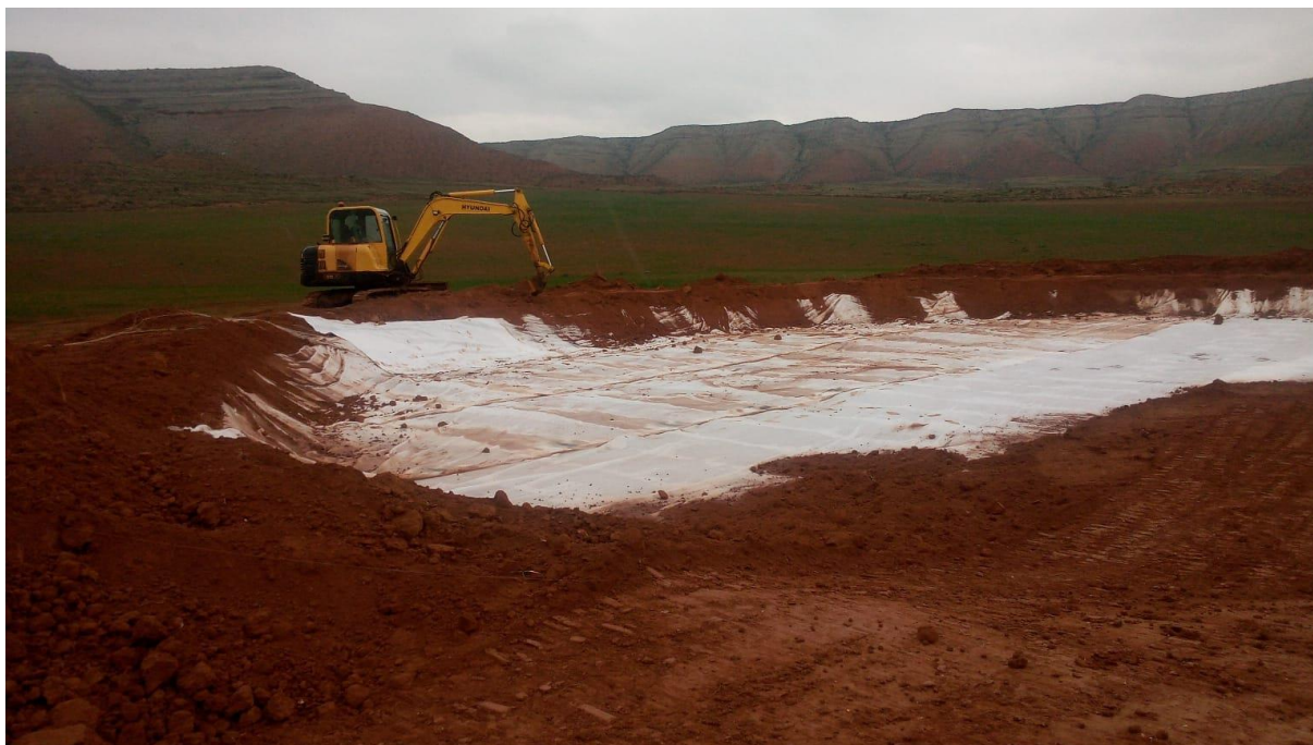
Foto 4: ejecución de balsa bebedero.
