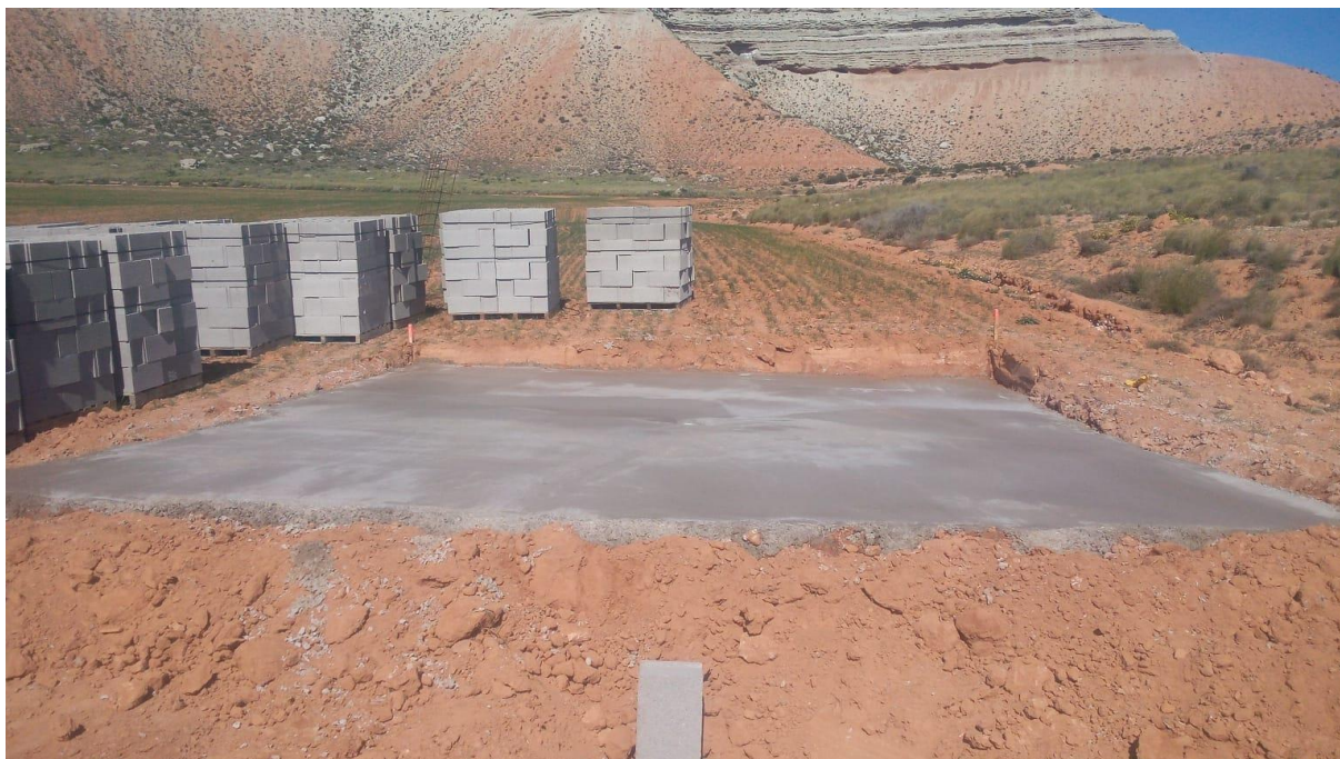
Foto 5: ejecución de losa para edificación del primillar.
