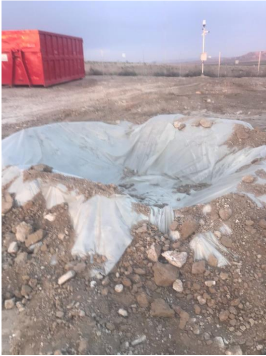
Foto 1: nueva balsa de hormigón.
