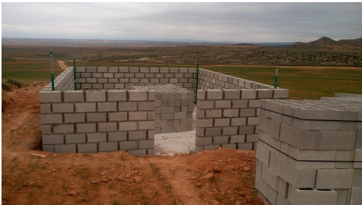
Foto 6: ejecución de paredes del primillar.
