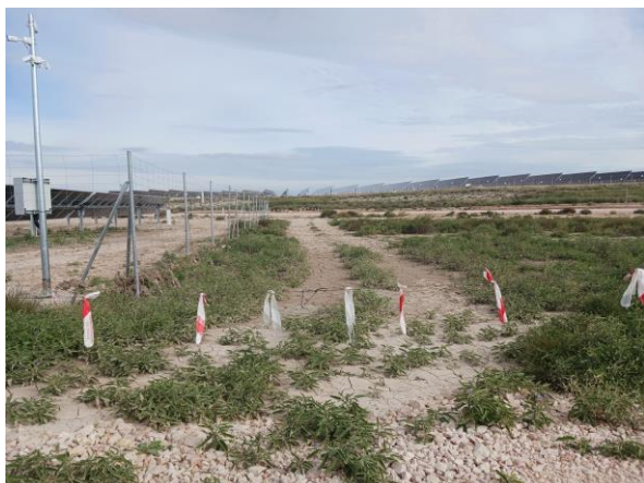
Foto 1. Zona HIC afectada y correctamente balizada
