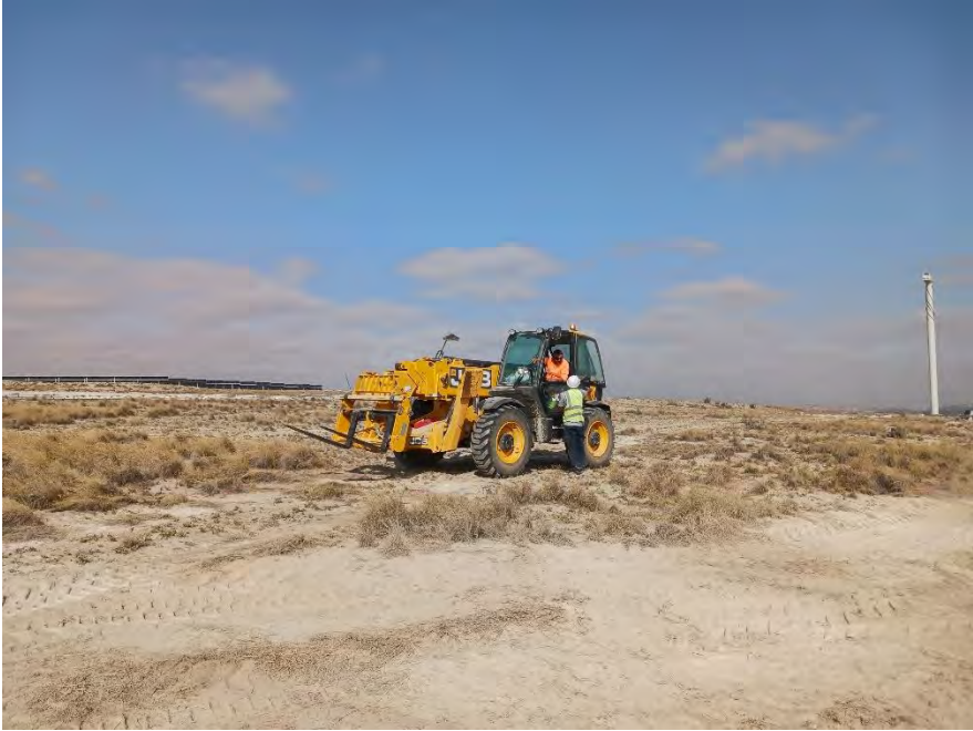
Figura 7: Trabajador cruzando sobre zona de HIC 1520 con maquinaria pesada.
