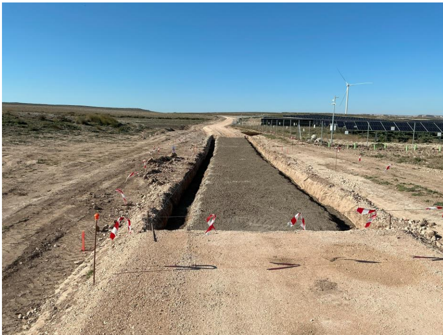
Foto 2: Ejecución de vado en vial exterior.
