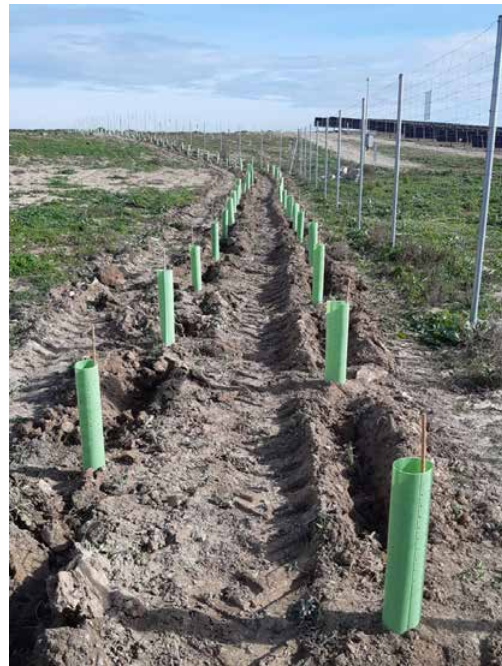
Foto 2: ejecución de pantalla vegetal.
