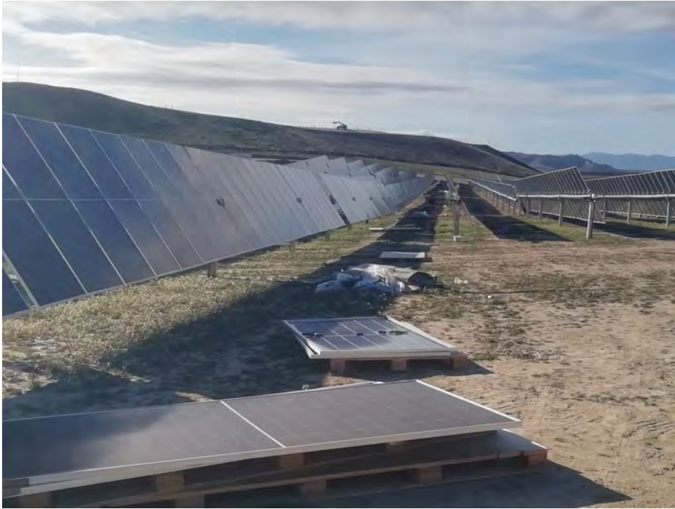
Imagen 3: Residuos en la obra.
