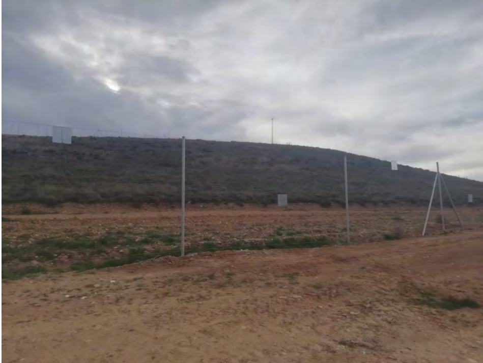
Imagen 5: Colocación de placas en vallado perimetral.
