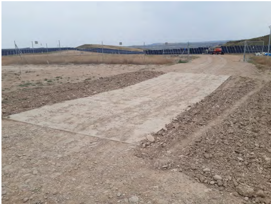
Imagen 2: Vado hormigonado en camino de entrada a la planta.
