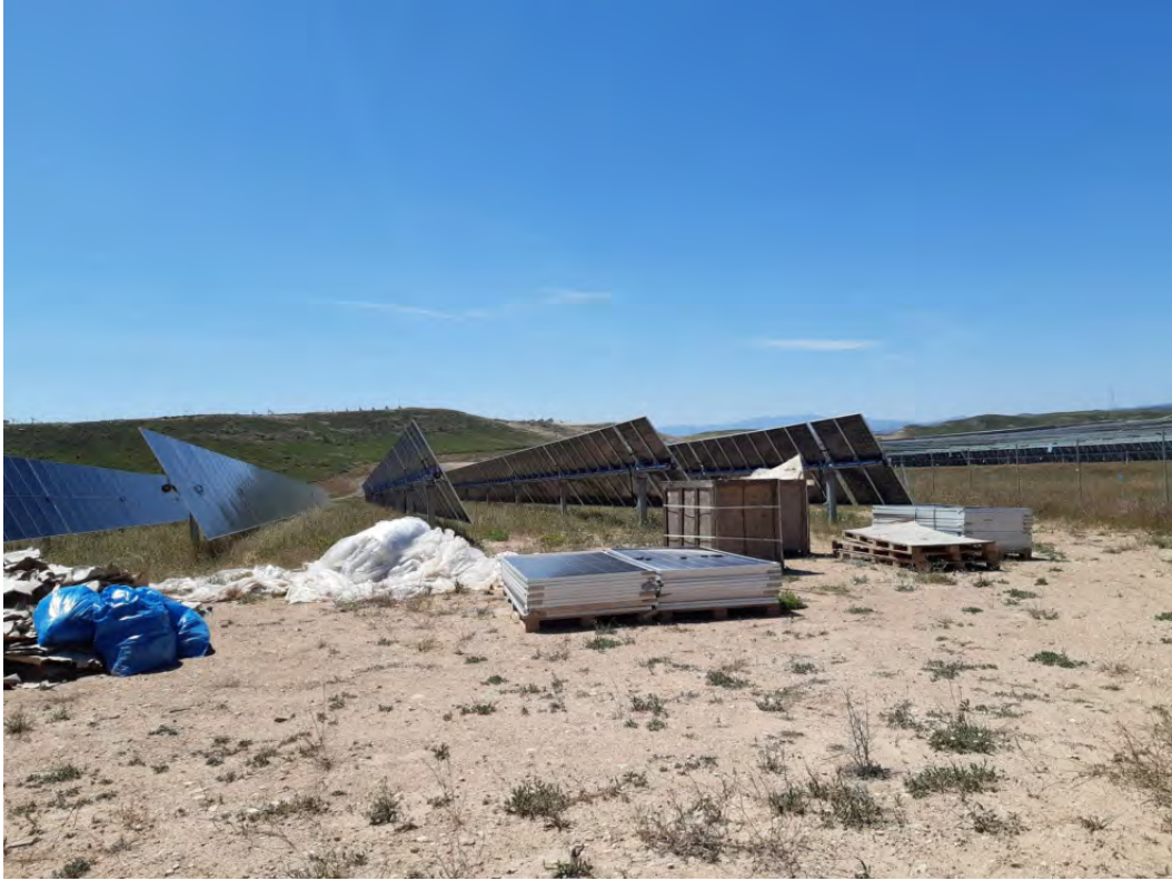
Fig. 1: Acopio de residuos.
