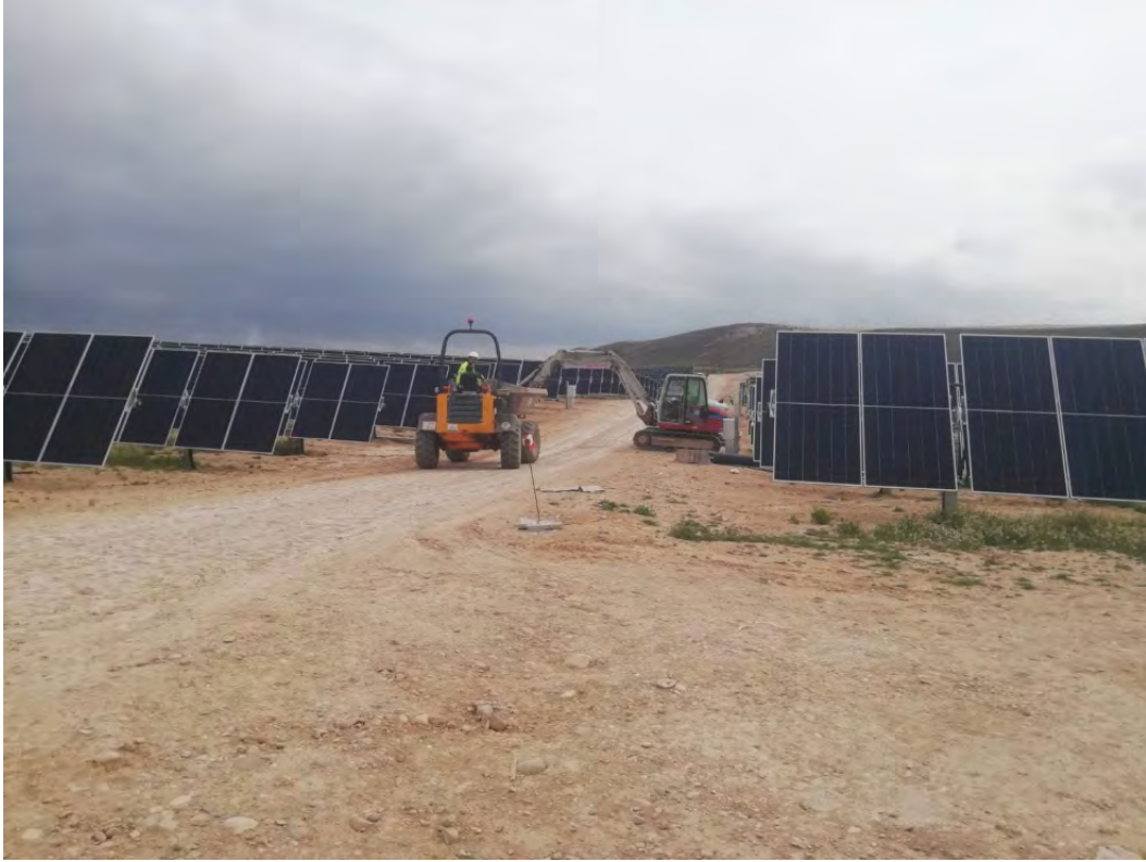
Fig. 1: Trabajos con maquinaria en parcela grande NV2.
