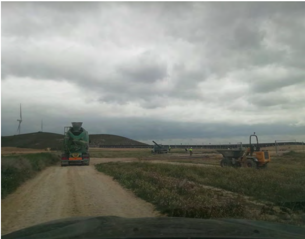
Fig. 2: Trabajos con maquinaria en parcela pequeña NV2.
