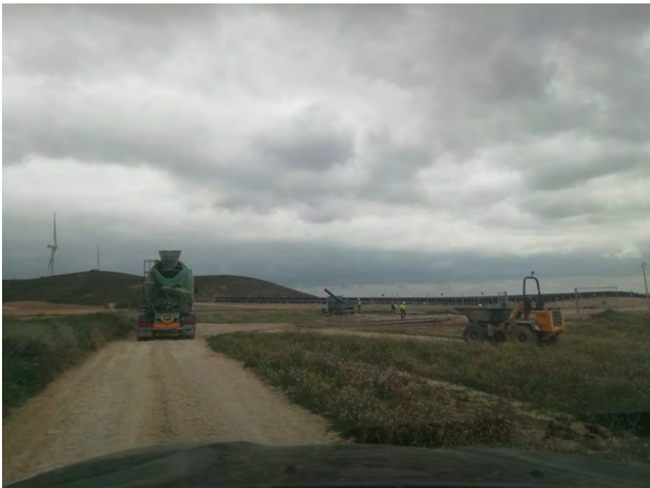
Imagen 6: Transporte de hormigón en la planta dentro del buffer respecto al primillar.
