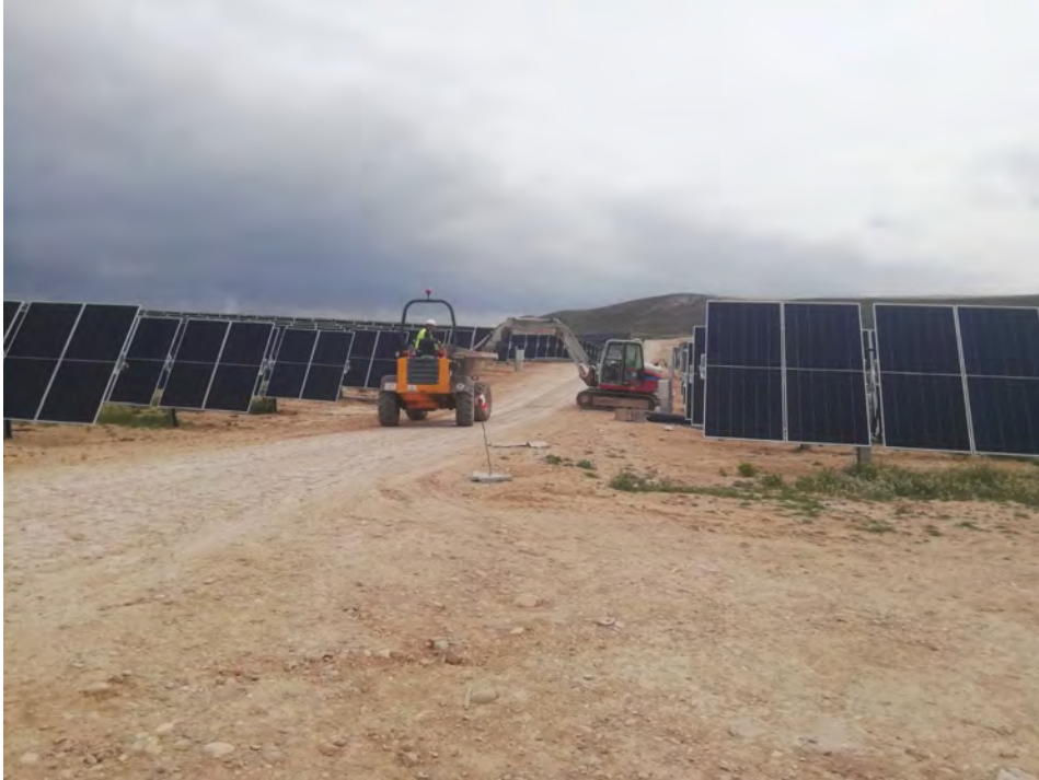
Imagen 5: Maquinaria trabajando en la planta dentro del buffer respecto al primillar.
