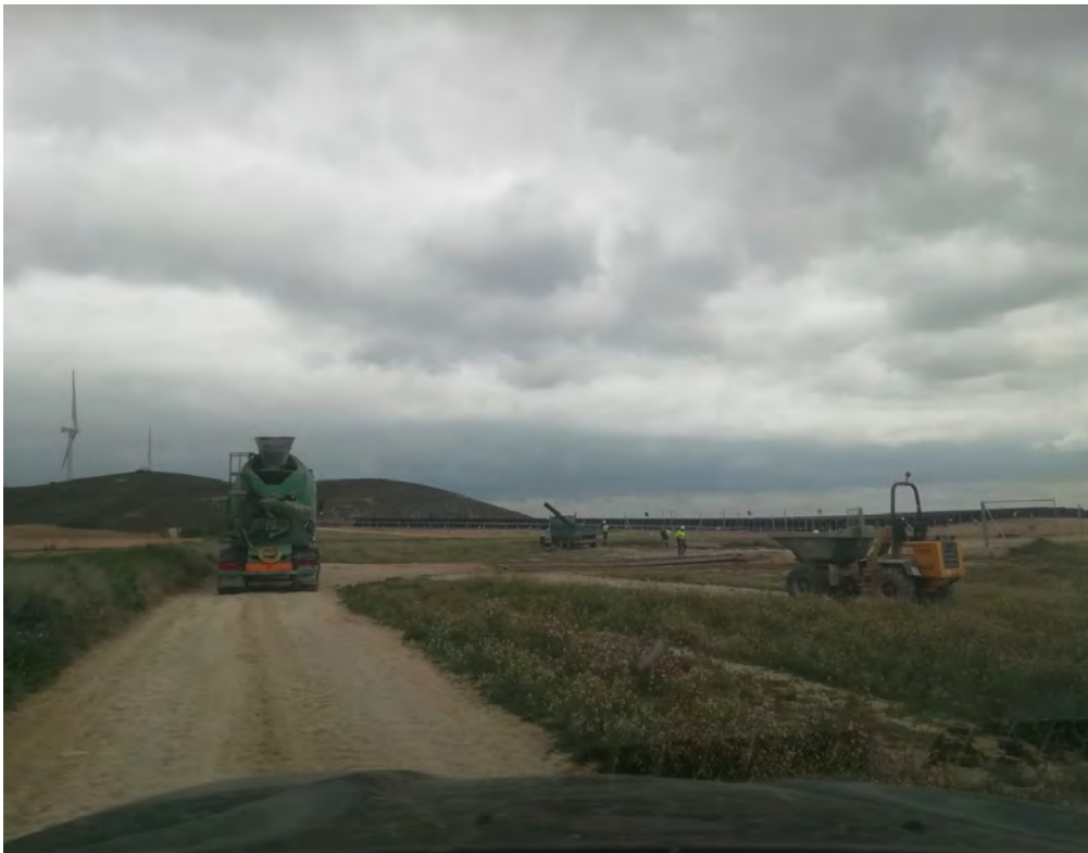
Fig. 2: Trabajos con maquinaria en parcela pequeña NV2.
