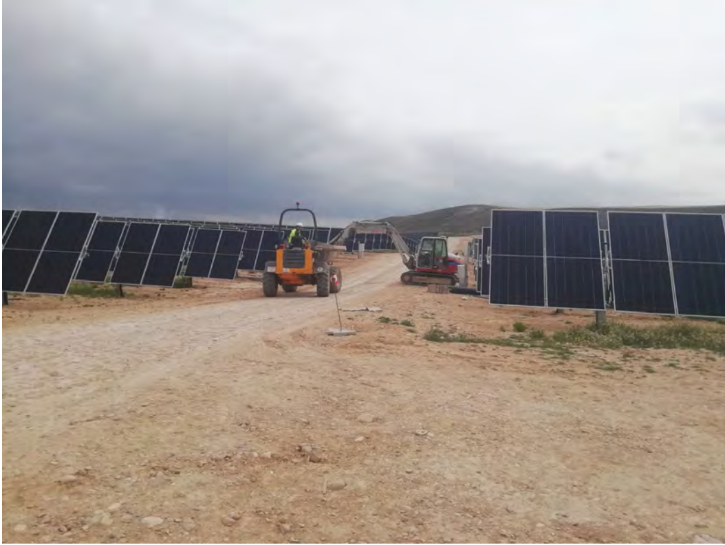
Fig. 1: Trabajos con maquinaria en parcela grande NV2.
