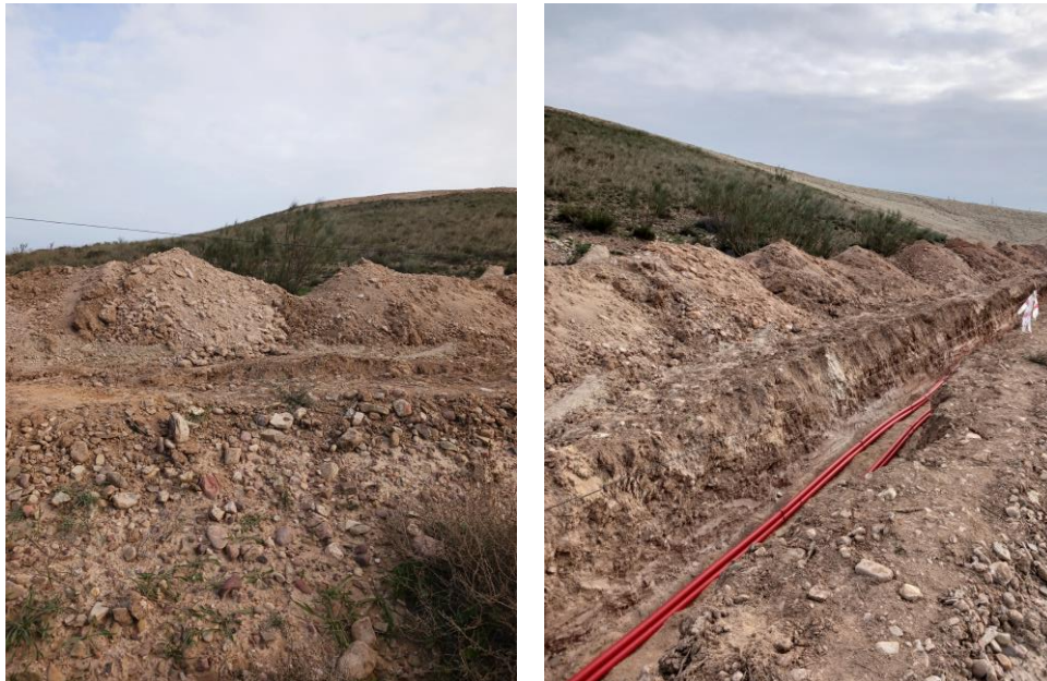
Figura 1. Apertura de zanja sin separar la tierra vegetal.
