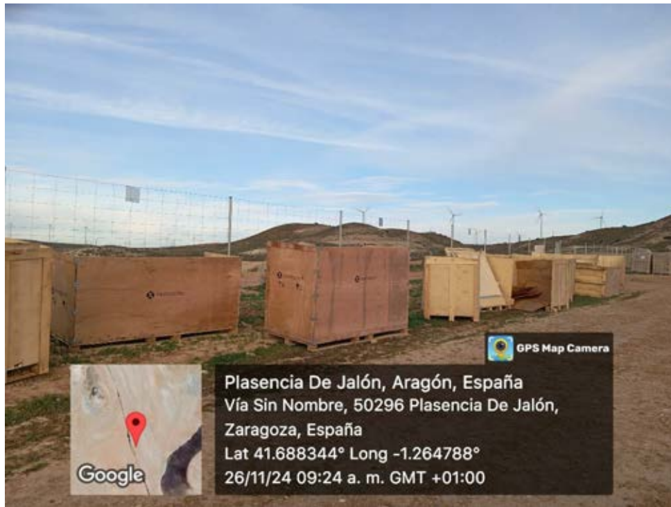
Figura 1. Cajas de madera depositadas sobre el cordón de tierra vegetal.
