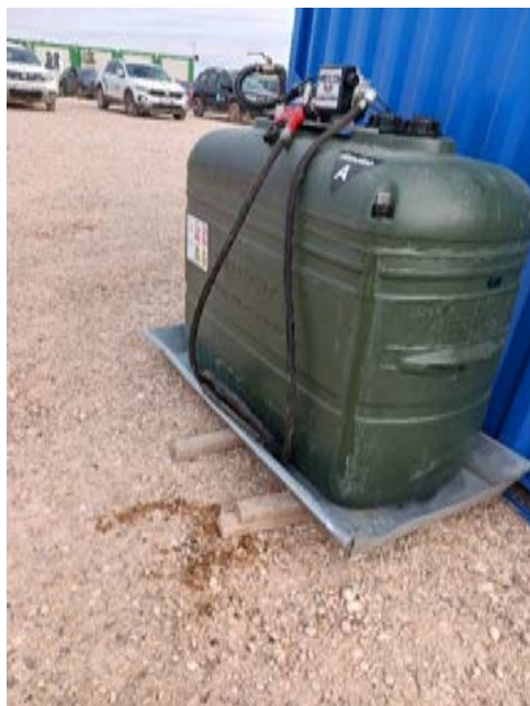
Figura 3. Pequeño vertido de gasoil.
