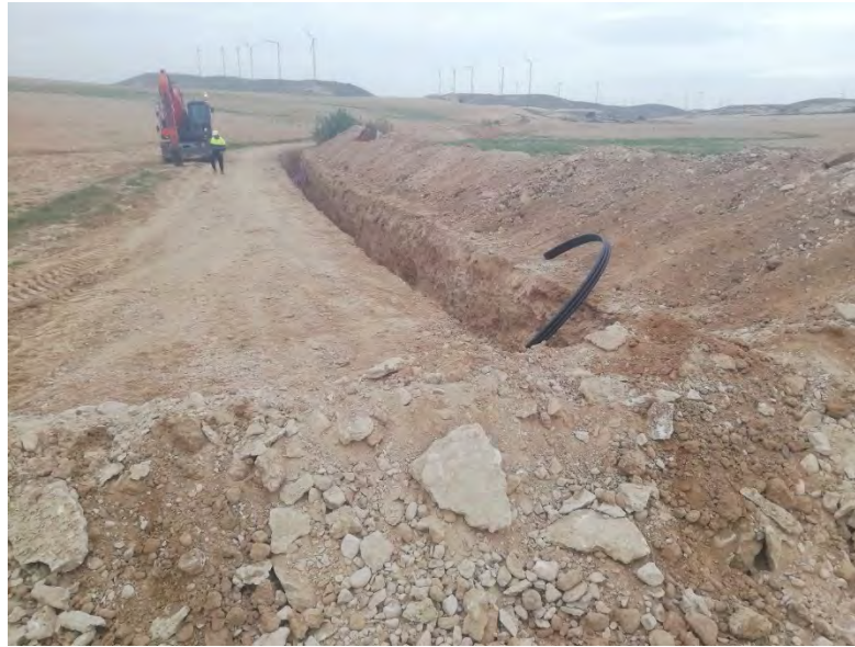
Figura 3: Zanja en camino cortado.
