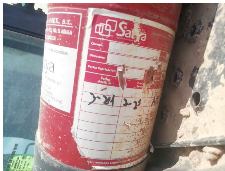
Figura 2. Extintor en maquinaria.
