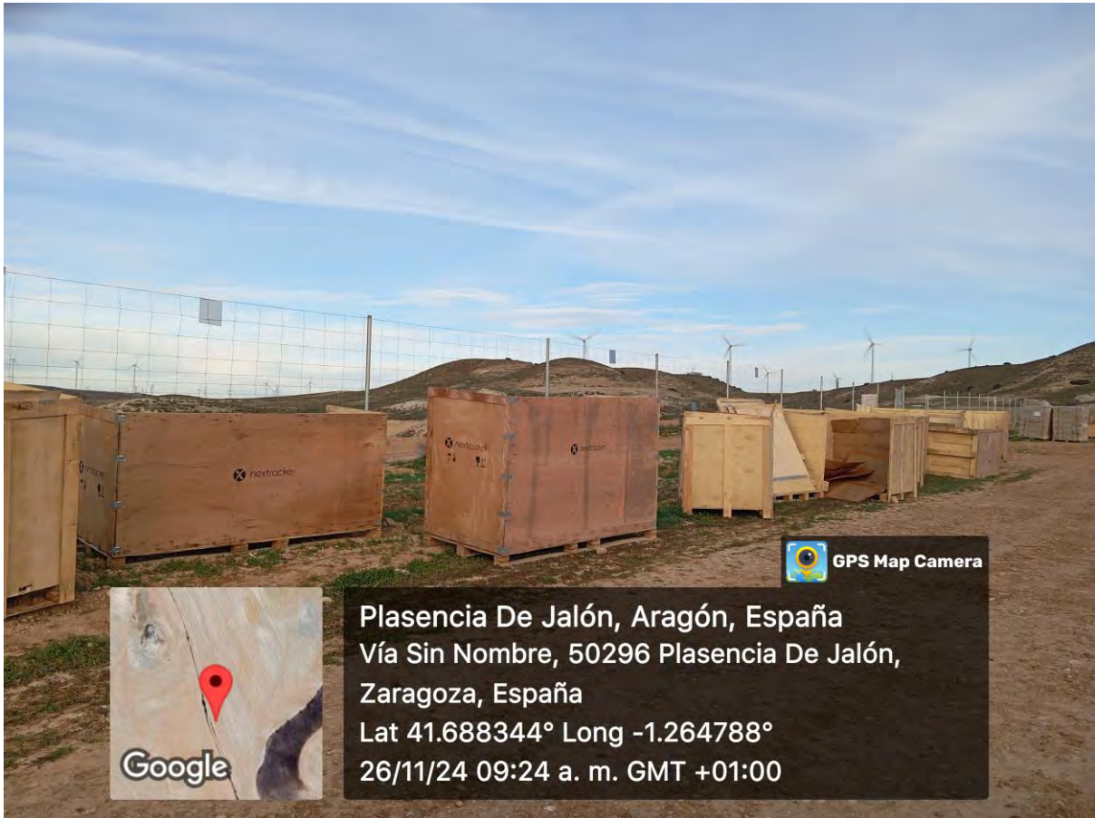
Fig 2. Acopio de cajas a día 26/11/2024
