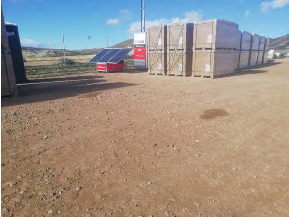
Imagen 5: Manchas de líquido contaminante.
