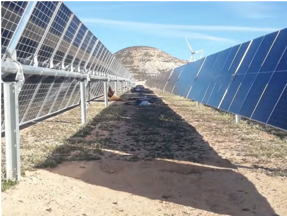
Imagen 2: Residuos en la obra.
