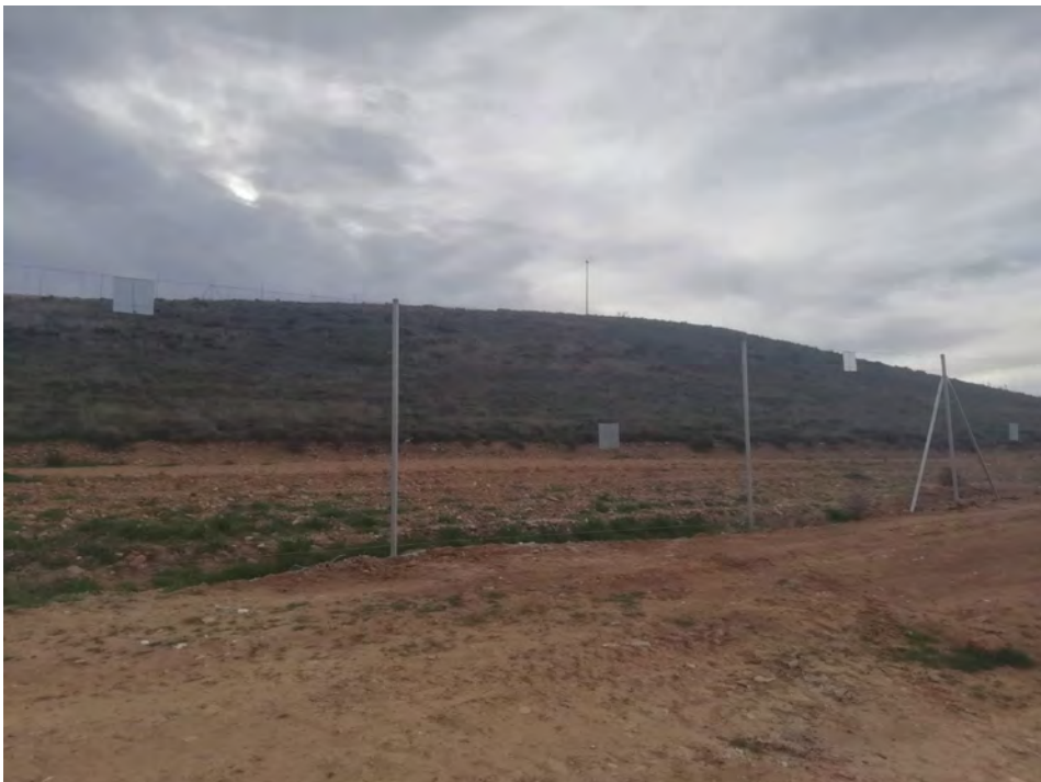
Imagen 6: Colocación de placas en vallado perimetral.
