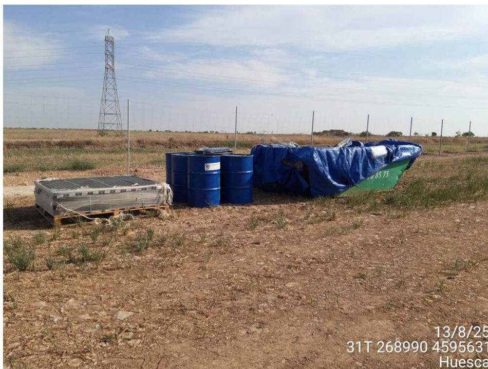
Imagen 5: Bidones residuos peligrosos y cubetos de retención.
