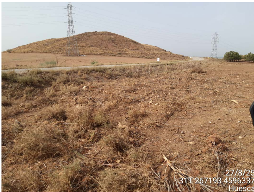
Imagen 10: Retirada de restos de vegetación.
