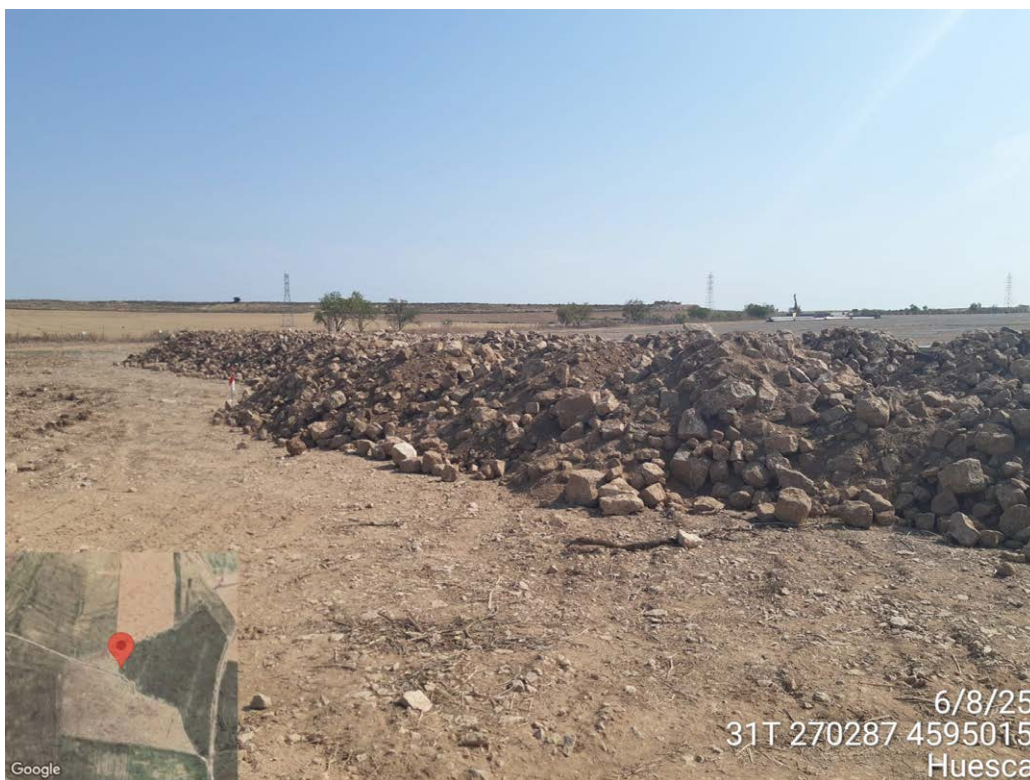
Imagen 15: Acopio dentro del vallado.
