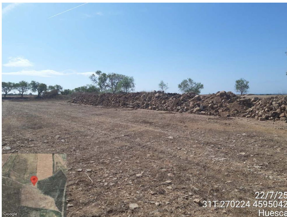
Imagen 14: Acopio de tierra en zona fuera de vallado.
