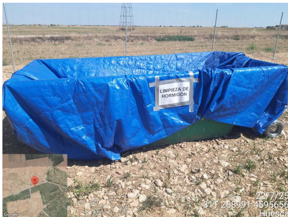
Imagen 1: Contenedor para el hormigón.
