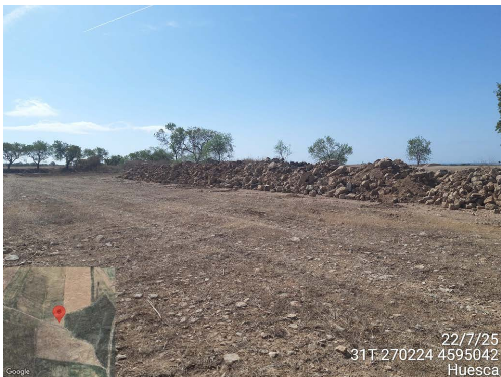
Imagen 7: Acopio de tierra en zona fuera de vallado.
