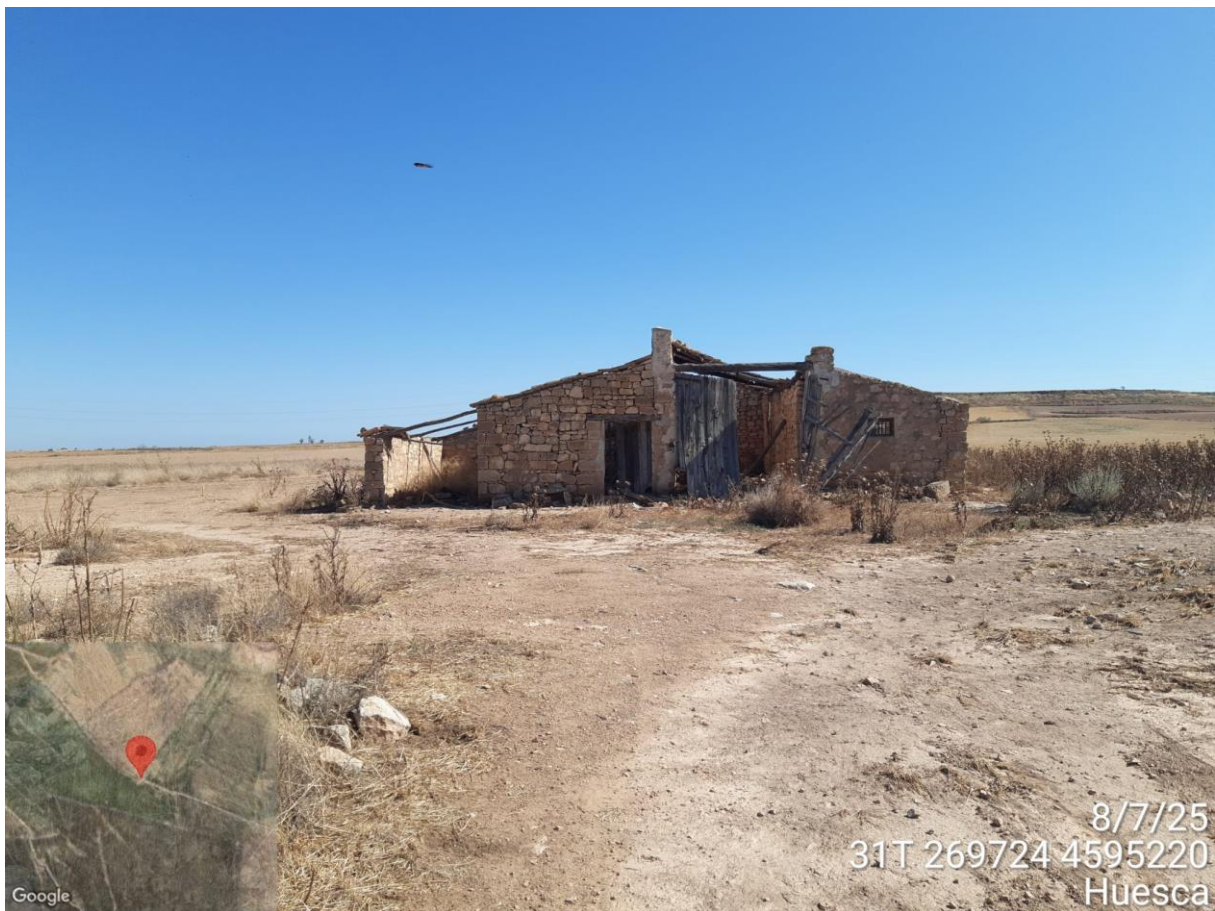
Fig. 1: Antes de la afección.
