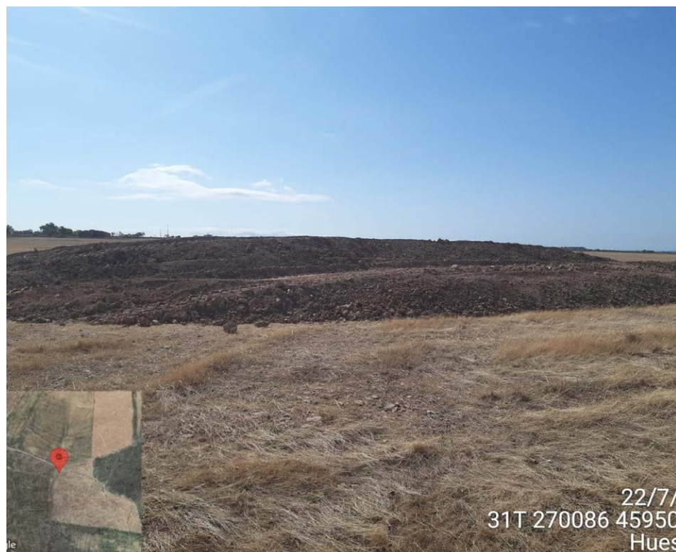
Imagen 6: Acopio de tierra vegetal.
