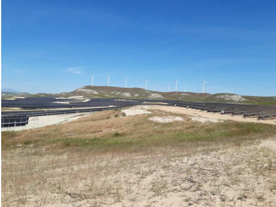
Imagen 13: Crecimiento de vegetación en zona afectada anteriormente.
