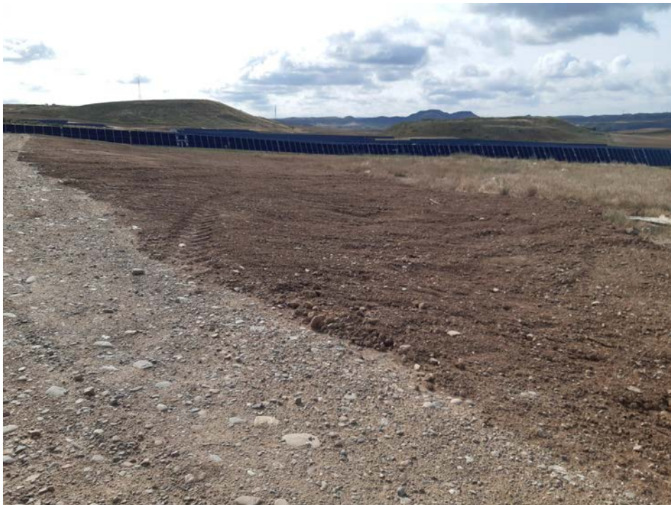
Imagen 14: Extendido de tierra de cunetas encima de tierra vegetal.
