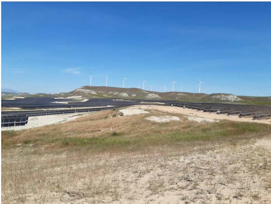
Imagen 8: Crecimiento de vegetación en zona afectada anteriormente.
