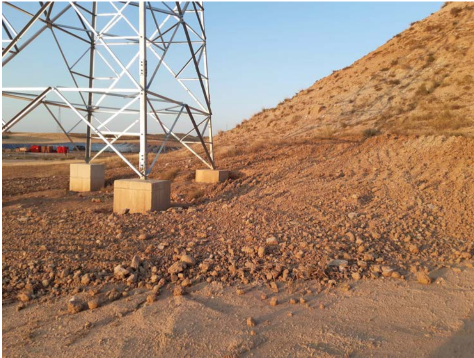
Imagen 11: Restauración apoyo LAAT.
