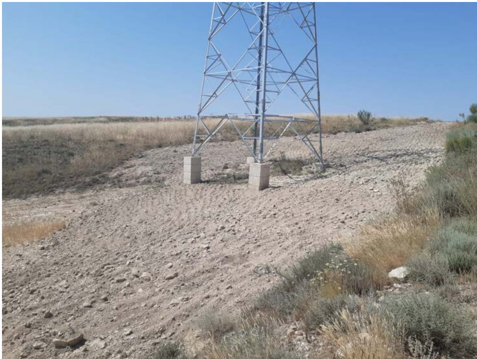
Imagen 10: Restauración apoyo LAAT.
