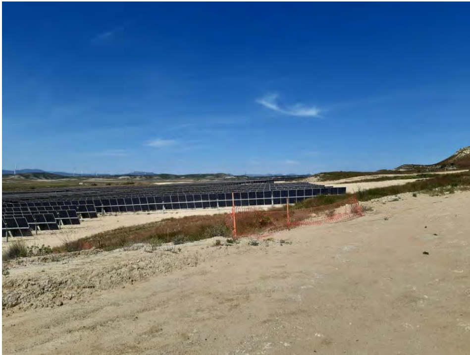
Imagen 12: Balizado correctamente colocado en zona de vegetación.
