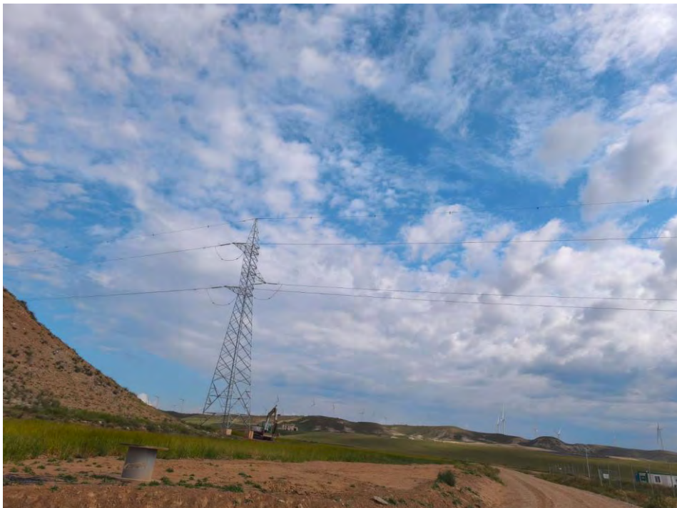
Imagen 9: Trabajo de picado de hormigón en apoyo 2 de la LAAT.
