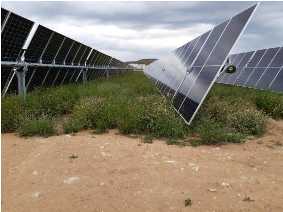
Imagen 13: Crecimiento de vegetación bajo paneles.
