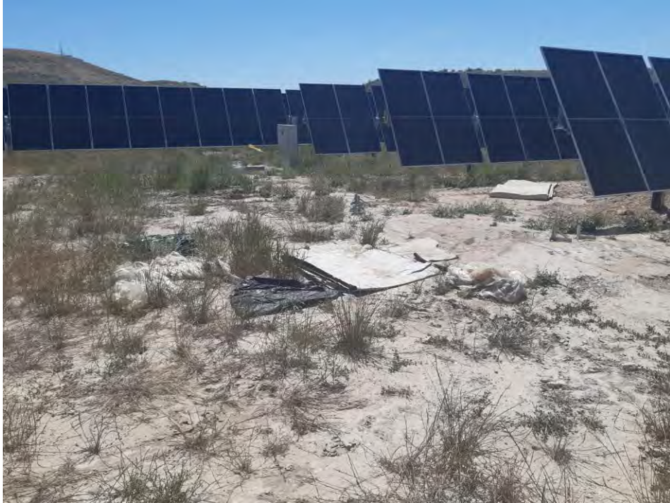
Imagen 4: Residuos en la planta.
