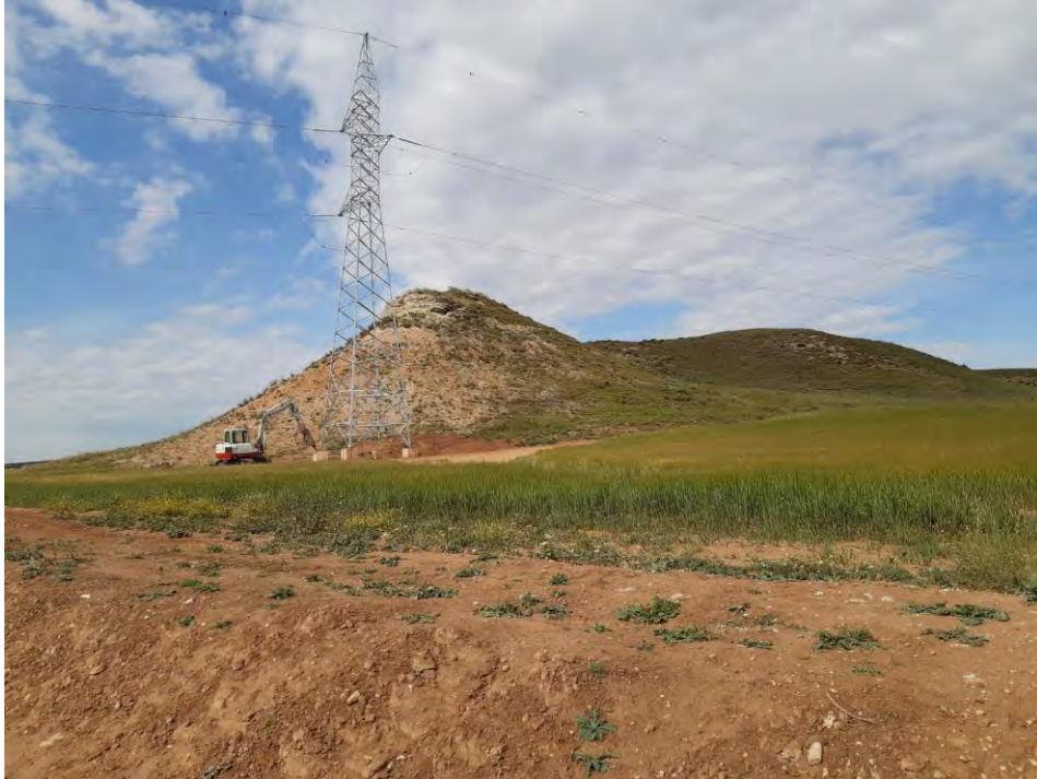
Imagen 8: Trabajo de picado de hormigón en apoyo 2 de la LAAT.
