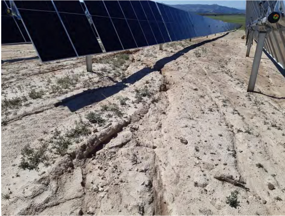
Imagen 1: Zona con erosión.
