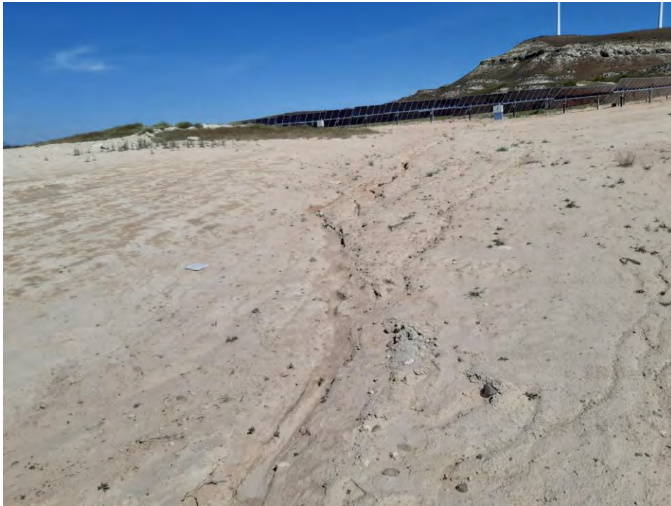
Imagen 2: Zona con erosión.
