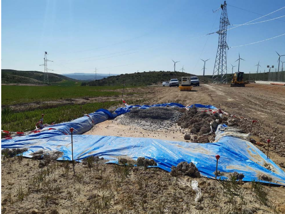
Imagen 5: Balsa para hormigón.
