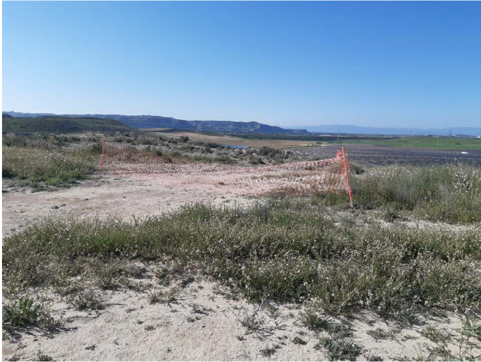
Imagen 9: Balizado mal colocado y rodadas en zona de vegetación.
