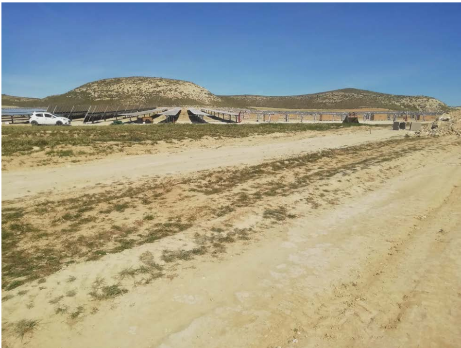
Imagen 10: Zona de paso compactada encima de acopio de tierra vegetal.
